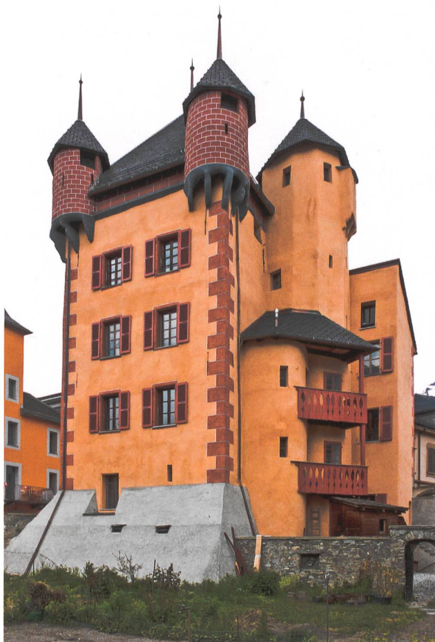
3: Sierre VS, tour des Vidomnes. Vue des façades sud et est avant la rénovation.
