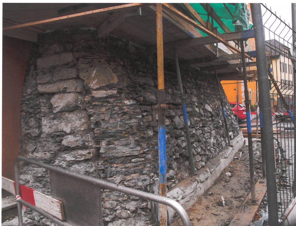
11: Sierre VS, tour des Vidomnes. Face orientale du contrefort nord. Le chaînage de gros blocs caractérise le premier état du contrefort, avant qu'il ne soit renforcé par un doublage.
