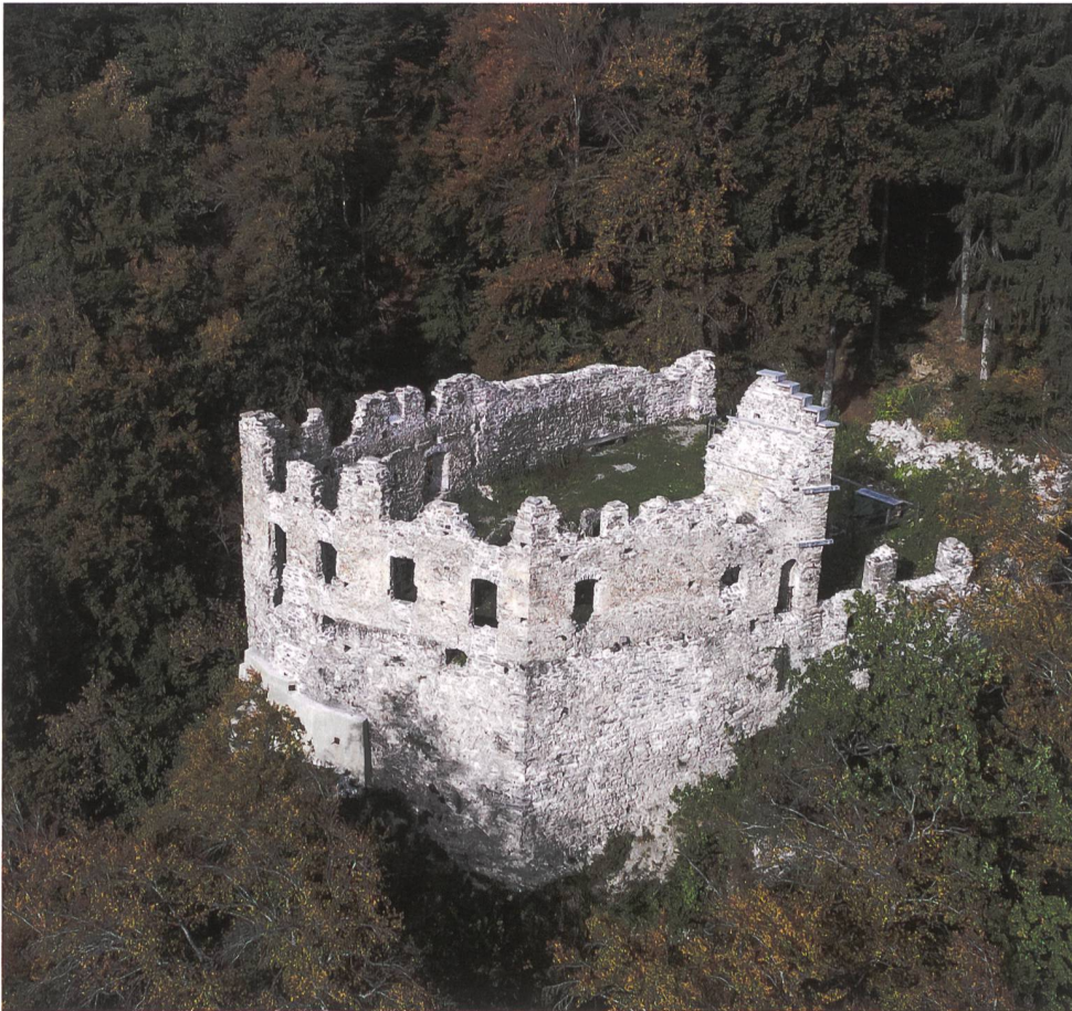
2: Wynegg GR. Luftaufnahme der sanierten Burganlage von Süden. Auf der Aufnahme ist deutlich der horizontale Mauerabsatz mit darüber zurückversetztem Mauerwerk zu sehen (Aufnahme 23.10.2019).
