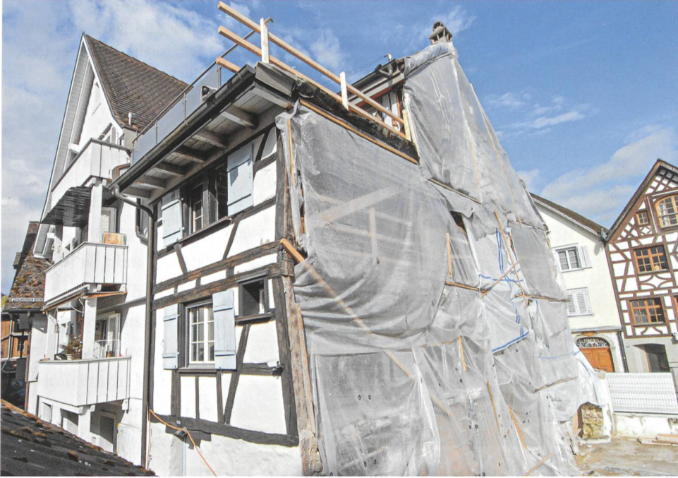
3: Steckborn TG. Seestrasse 105, Südfassade. Teile der Fassade konnten auf 1422 datiert werden.
