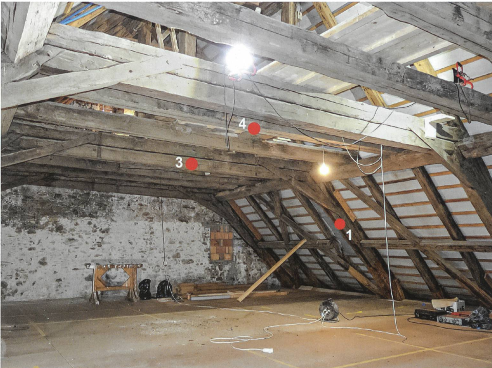
5: Steckborn TG, Kirchgasse 7. Ansicht des liegenden Dachstuhls von 1591/92.
