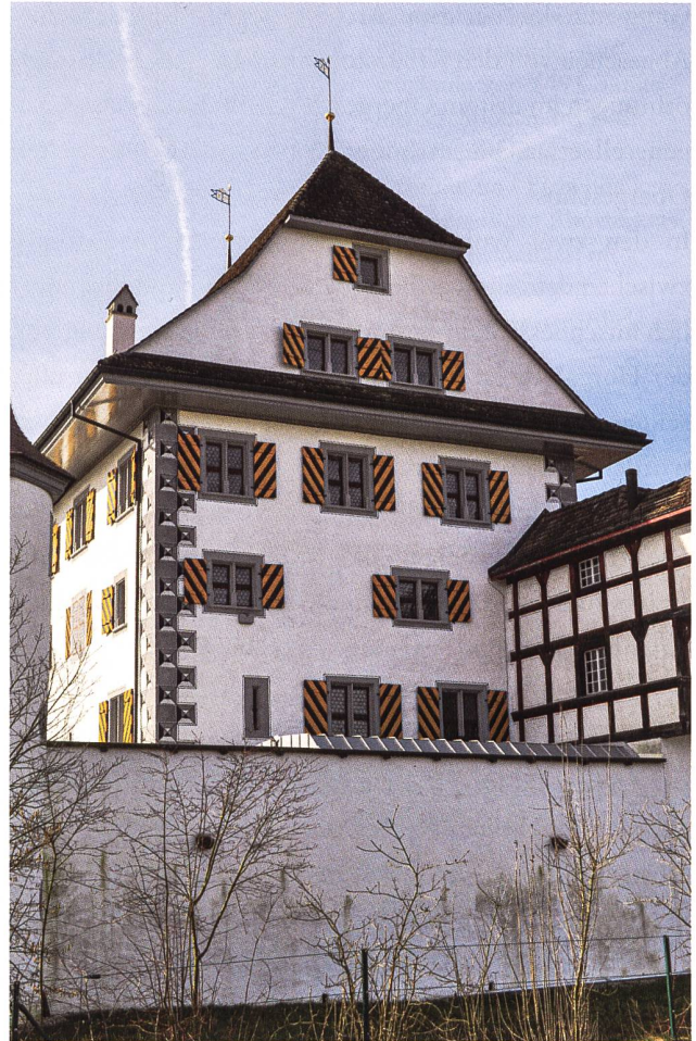
30: Ettiswil LU. Schloss Wyher. Hauptgebäude, errichtet um 1510. Ansicht von Osten.
