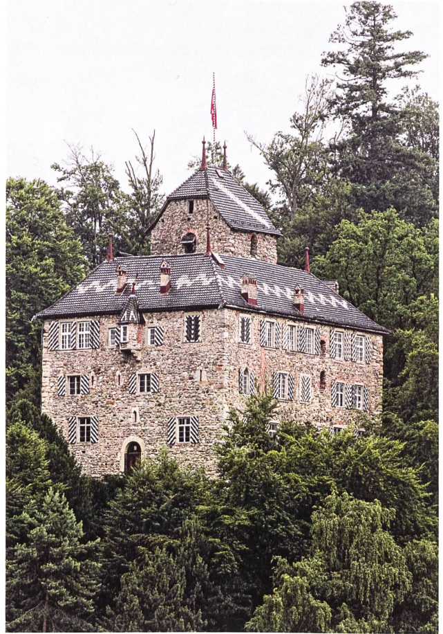
7: Schloss Buonas. Ansicht von Norden. Zustand 2015.
