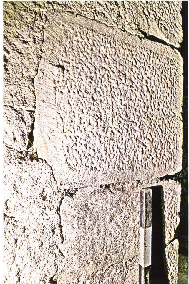
14: Schloss Buonas. Kellerraum. Steinbearbeitung an der Einfassung einer Fensternische. Blick nach Norden.
