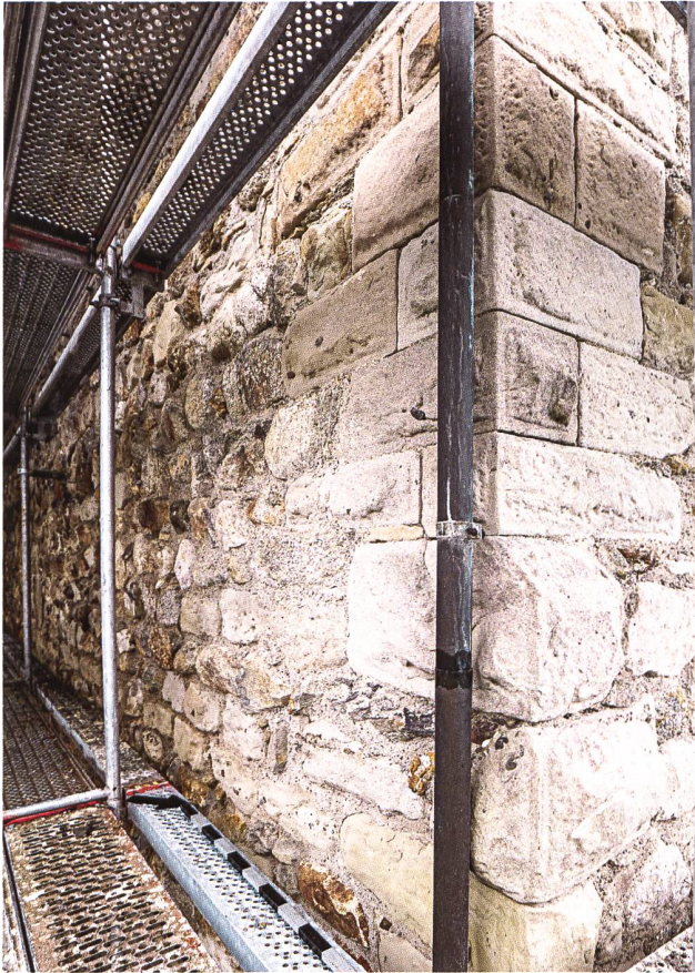
10: Schloss Buonas. Eckverband Ost mit Rücksprung. Blick nach Westen.
