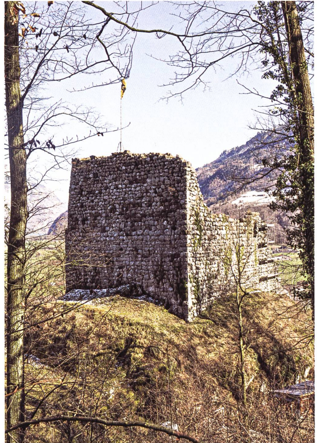
18: Glarus Nord GL. Oberurnen, Ruine Vorburg. Ansicht von Westen.
