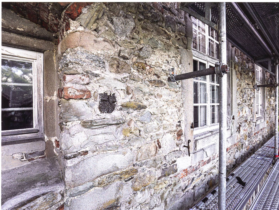
27: Schloss Buonas. Nordwestfassade. Aufstockung von 1495. Links mit Stichbogen aus Backsteinen überfangene Öffnung und Eichenbalken des ehemaligen Aborterkers. Rechts ehemaliges, im 18. Jh. umgestaltetes Kreuzstockfenster. Blick nach Süden.
