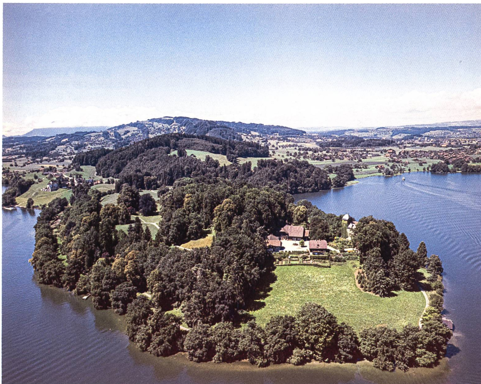
2: Risch ZG. Halbinsel Buonas mit der Schlossanlage an der Spitze. Links im Hintergrund die Kirche St. Verena in Risch, rechts im Hintergrund das heutige Dorf Buonas. Foto 1988. Blick nach Südwesten.
