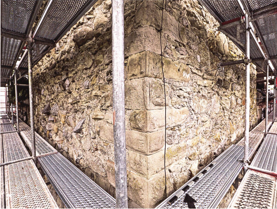
19: Schloss Buonas. Südecke des Turms und Mischmauerwerk aus grossen Findlingen und kleinteiligem Bruchsteinmaterial. Blick nach Norden.
