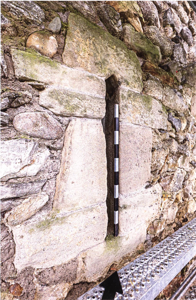
12: Schloss Buonas. Südostfassade. Schiesschartenartiges Schlitzfenster. Blick nach Norden.
