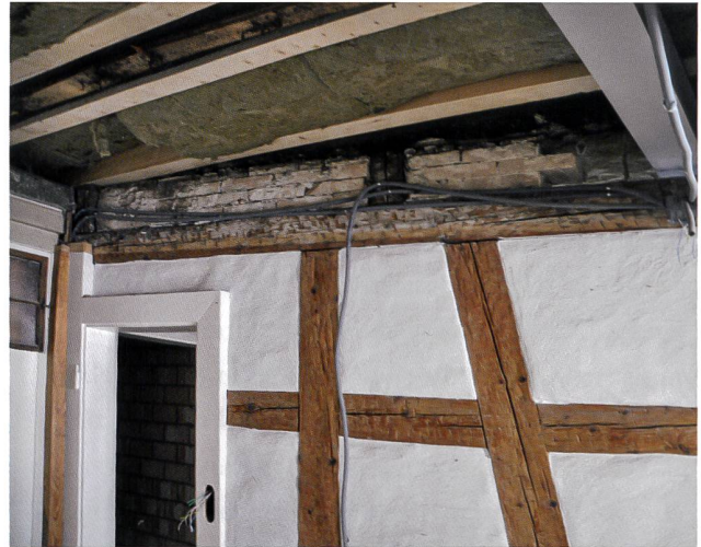
20: Stein am Rhein SH, Brodlaubegass 15. Fachwerkwand im OG mit Aufmauerung aus Backsteinen, um die volle Raumhöhe zu erreichen.
