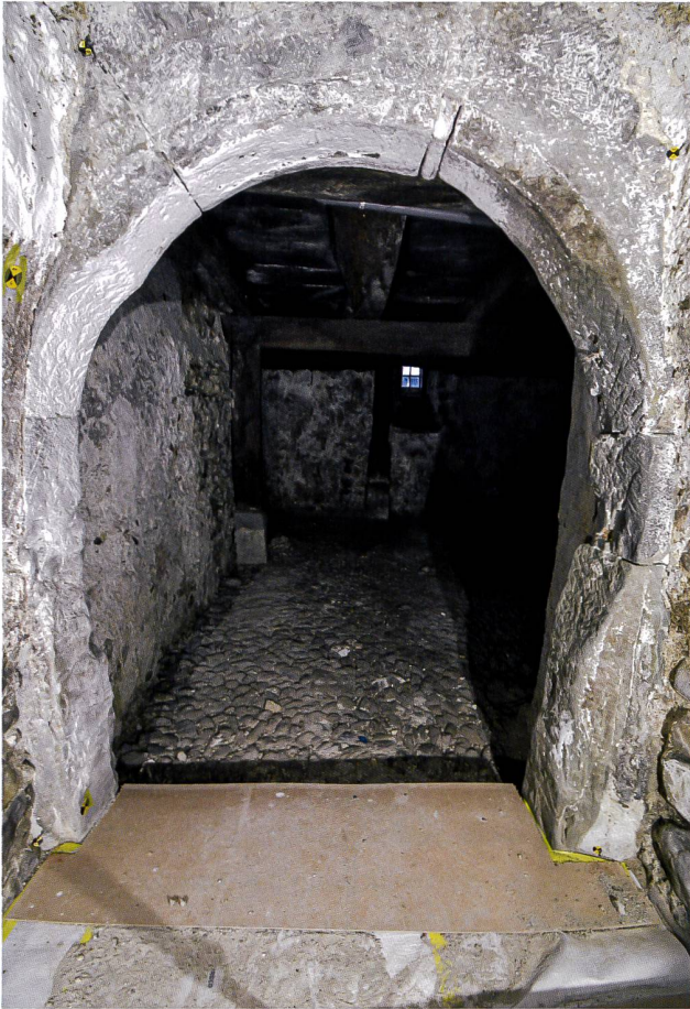
19: Stein am Rhein SH, Brodlaubegass 15. Kellerportal mit abgearbeitetem Gewände, um Durchlass für Weinfässer zu schaffen.
