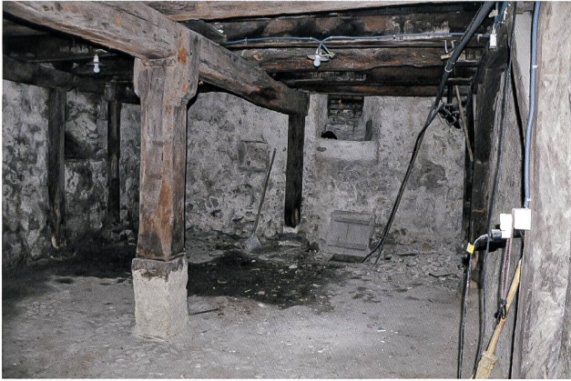
13: Stein am Rhein SH, Brodlaubegass 15. Keller aus Bauphase II. Blick nach Norden.
