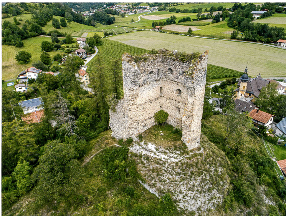
1: Paspels GR, Alt-Süns. Überblick über die Anlage im heutigen Zustand. Foto 2020.
