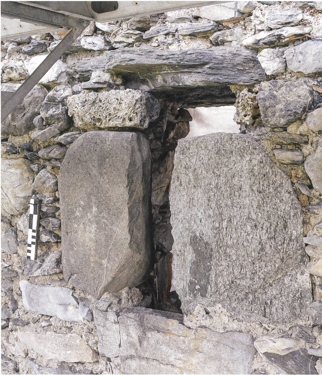
9: Pfäfers SG, Ruine Wartenstein, 2019. Untere Burg, Palas. Mauer M203, Fenster 2.14. Äusseres Fenstergewände aus grob behauenen Steinen von unterschiedlicher Qualität, von Nordosten. Die der Scharte zugewandte Kante der Sandsteinplatte ist grob abgefast. Die unter dem Sturz verbauten Quader sind aus Tuff, wobei der Stein auf der rechten Seite grösstenteils ausgebrochen ist.
