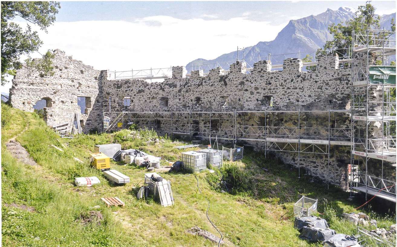
7: Pfäfers SG, Ruine Wartenstein, 2019. Untere Burg, Palas. Blick auf die Baustelle und die auf der Innenseite grösstenteils fertig sanierten Mauern M201–M204, von Süden.
