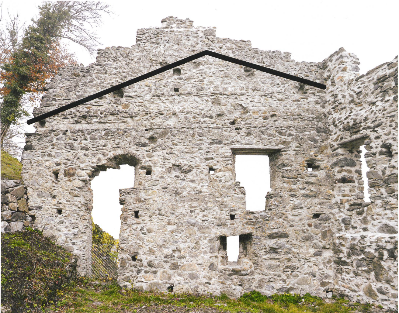
8: Pfäfers SG, Ruine Wartenstein, 2019. Untere Burg, Palas. Stirnseitige Mauer M201 mit Resten des Treppengiebels, von Südosten. Schwarz eingezeichnet ist der asymmetrische Querschnitt des Satteldaches.
