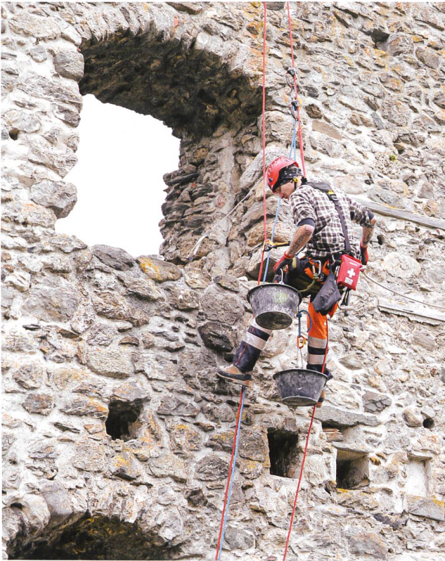
4: Pfäfers SG, Ruine Wartenstein, 2019. Obere Burg, Innenfassade der Mauer M101 des Wohnturms. Der Seilarbeiter repariert eine Schadstelle in ca. vier Metern Höhe, von Südosten.
