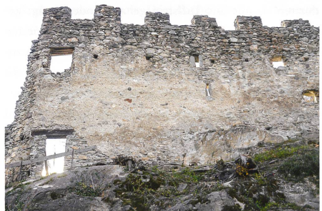
12: Pfäfers SG, Ruine Wartenstein, 2019. Untere Burg, Palas. Grossflächig erhaltener Verputz auf der Aussenfassade der Mauern M203 und M204, von Nordosten.
