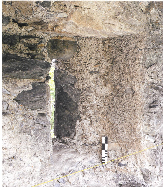
10: Pfäfers SG, Ruine Wartenstein, 2019. Untere Burg, Palas. Mauer M204, Fenster 2.8. Beinahe vollständig erhaltener Putz in der rechten Fensterleibung, von Nordwesten. Der Putz lief mindestens teilweise auf den gegen die Scharte hin grob abgefasten Gewändestein.
