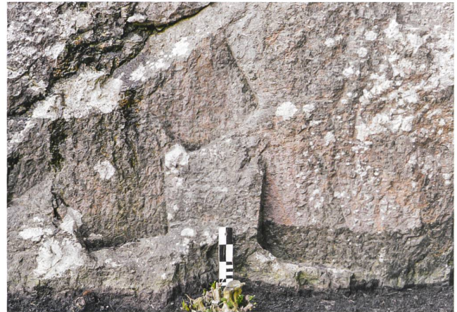
5: Pfäfers SG, Ruine Wartenstein, 2019. Obere Burg, innere Ecke beim Anschluss der Ringmauer an den Wohnturm. Wangen von Keiltaschen in der Felsoberfläche, von Nordwesten. Sie zeigen, wie der anstehende Fels zur Vergrößerung des Innenraums abgearbeitet wurde.
