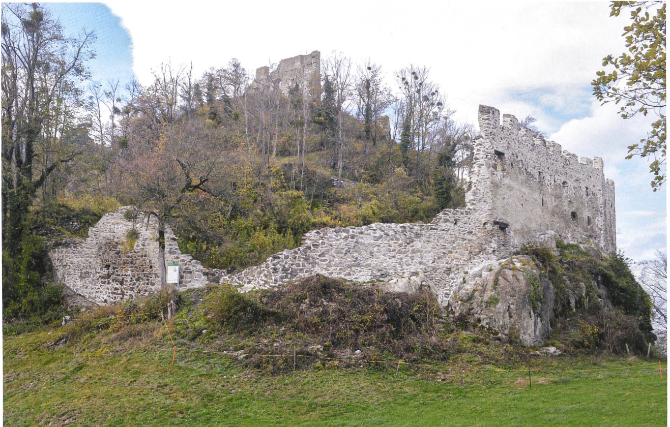
17: Pfäfers SG, Ruine Wartenstein, 2019. Gesamtanlage, von Südosten. Im Hintergrund die Obere Burg, darunter die frisch in Stand gestellte Untere Burg.
