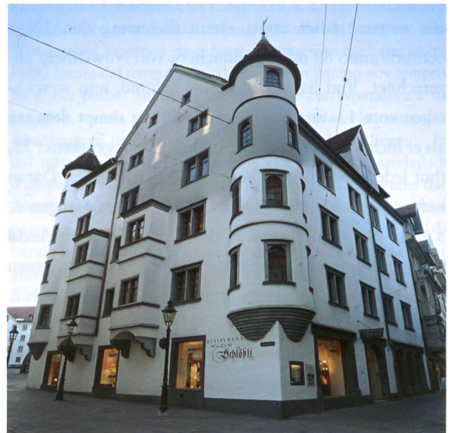
13: St. Gallen, Schössli an der Spisergasse. Für Lorenz II Zollikofer erbaut 1586–1590.
