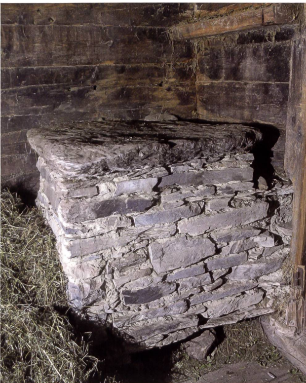
42: Vorgänger der sich erst nach 1500 durchsetzenden Giltsteinöfen: Aus Feldsteinen aufgemauerte Stubenöfen, hier im sogenannten «Bachhuis Murmann» in Ferden, das heute als Scheune dient (1456d). Ofenkörper: Höhe 80 cm, Breite 73 cm, Tiefe 106 cm (Foto 2021).
