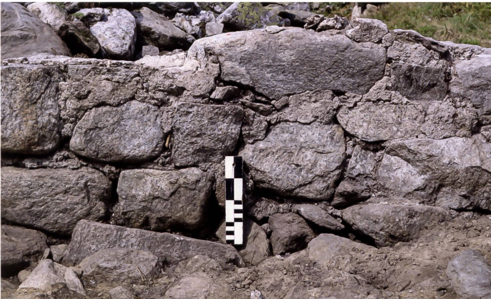
26: Blatten (Lötschen) VS, Kühmatt 2019. Haus H24, Mauer M24.1, innen, von Südosten. Mauerstruktur mit Resten des originalen Rasa-Pietra-Putzes.
