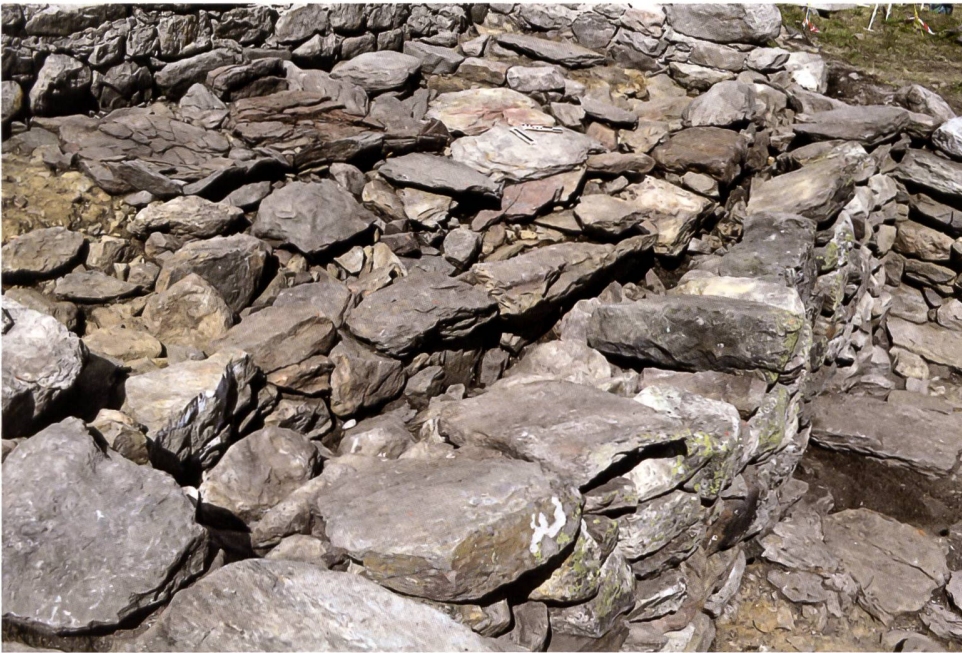
30: Blatten (Lötschen) VS, Kühmatt 2019. Haus H24. Mauerkronen der Mauer M24.6 (links) und der nachträglich davor aufgemauerten Mauer M24.5, von Südwesten.
