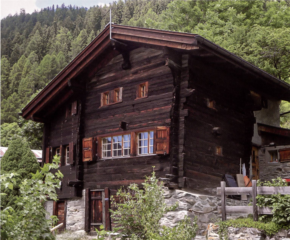
43: Typisches Wohnhaus des 15./16. Jh. im Tal: Haus Professor Niederer in Ferden, 1531d, mit späterem Anbau West (links im Bild) und im 20. Jh. vergrößerten Fenstern der Wohnstube (Foto 2021).
