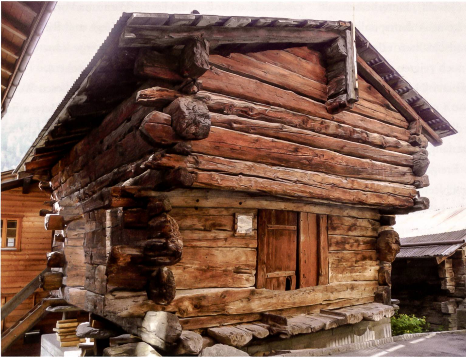
39: Rotigostadel in Ferden (Innenmasse 4,1 × 4,5 m), Parzelle GIS Nr. 420 (Foto 2018).
