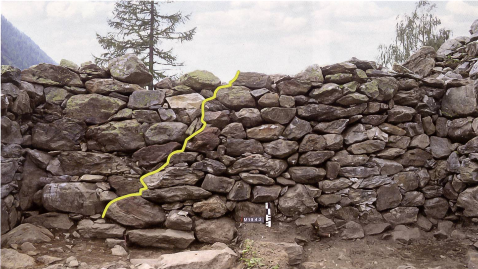
12: Blatten (Lötschen) VS, Kühmatt 2019. Haus H19, Mauer M19.4-2, von Nordosten. Gelb eingezeichnet ist der Verlauf der Fuge zwischen dem Mauerwerk der Phase II (rechts) und der Phase III (links).
