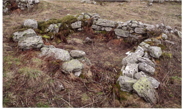
20: Blatten (Lötschen) VS, Kühmatt 2019. Haus H23, von Südwesten. Zustand im Frühjahr 2019 kurz nach der Schneeschmelze.
