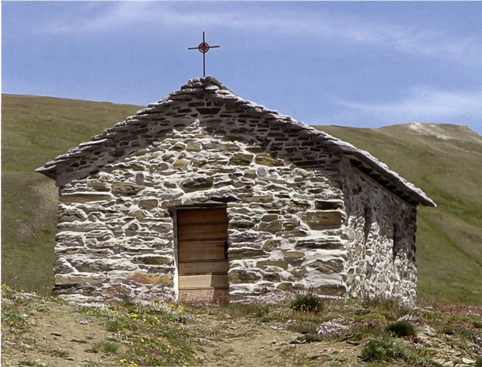
40: Furggehäller (Gemeinde Grengiols, VS). Dank einem Balken ins 17. Jh. dendrodatierte Kapelle, Sanierung 2008–2014 (Foto 2018).
