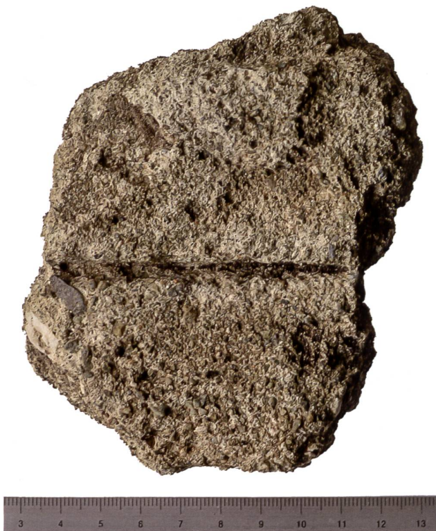
27: Blatten (Lötschen) VS, Kühmatt 2019. Haus H24. Mörtelbrocken mit tief eingekerbtm Fugenstrich.
