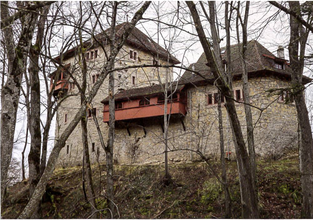
22: Metzleren-Mariastein. Burg Rotberg. Ansicht von Süden 2022.
