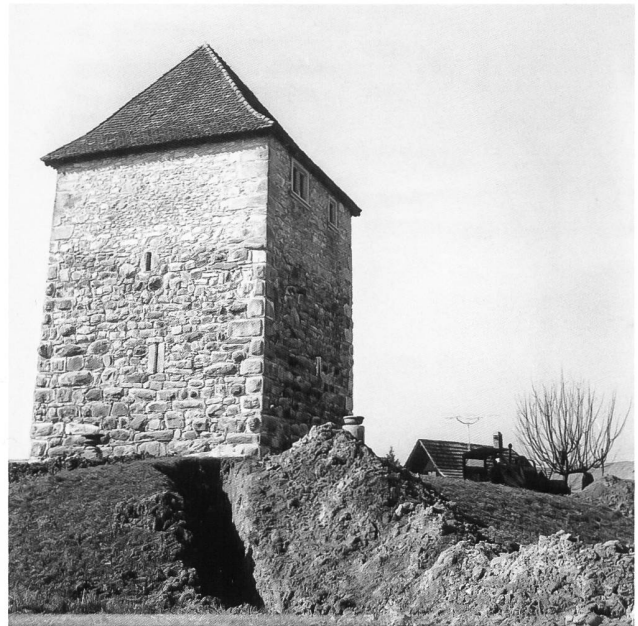
9: Halten, Turm. Ansicht von Westen während den Sondierungen 1966.
