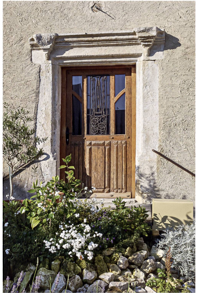
20: Rue de Kiffis 25/31. Das Haustürgewände entspricht der Eingangstür der Huttlinger Mühle von 1626.
