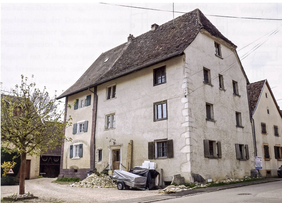
21: Das Haus Rue de Kiffis 25/31 ist dendrodatiert 1629–1630 mit einem älteren Kern aus dem 16. Jh. Im ersten Obergeschoss war wahrscheinlich ein Saal. Das zweite Obergeschoss diente wohl als Getreidelager.
