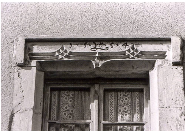
15: Rue de Wolschwiller 1. Am Doppelfenster Stabwerk und Kielbögen von 1554. Der Mittelpfosten fehlt.
