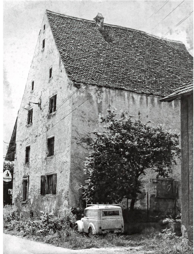
17: Rue de Kiffis 42, ehemals Restaurant aux Deux Clefs. Das grosse Haus von 1619–1620d hat einen Kern von 1557–1558d. Das zweite Obergeschoss und der Dachstock dienten wohl als Getreidelager. Aufnahme 1973.
