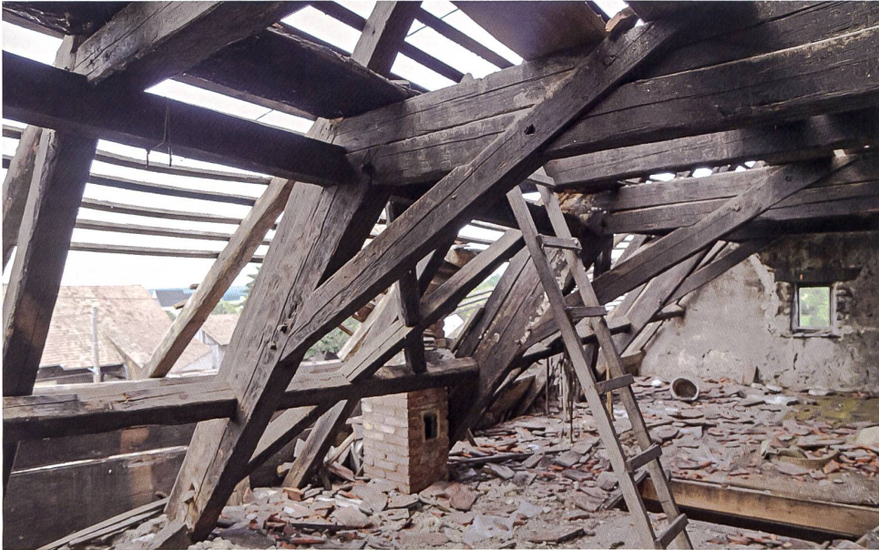
26: Das Haus in Wolschwiller Rue d'Oltingue 10 datiert 1604, während des Abbruchs 2013. Der Dachstock wurde im November 2021 in Lutter hinter der Kirche wieder aufgestellt. Er soll die alte Handwerkstechnik bezeugen und nach Fertigstellung als Mehrzweckraum dienen.
