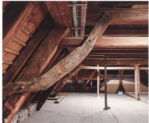
16: Flums SG, Kirche St. Justus. Schiff. a zweigeschossiger liegender Dachstuhl mit bogenförmigen Kopfstreben von 1451d. Blick gegen Osten. b bogenförmige Kopfstrebe.
