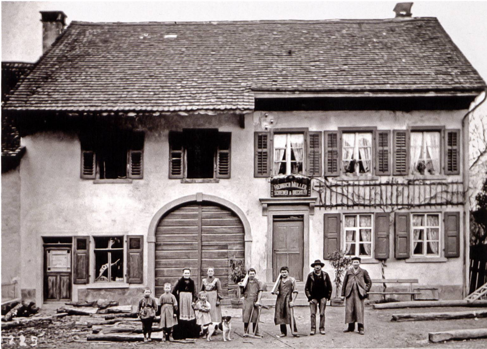
23: Liegenschaft Baselstrasse 4. Stall und Heubühne sind ausgebaut und werden zu Wohn- und Werkstattzwecken genutzt (Schreinerei-Drechslerei Müller). Fotografie von 1907.
