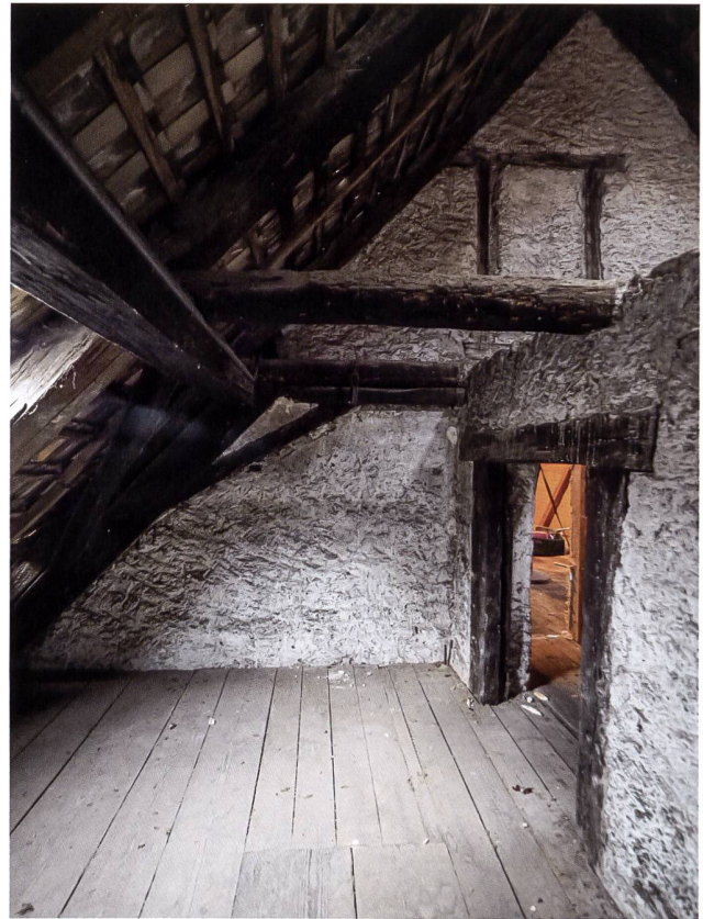
2: Dachraum in einer Liegenschaft in der Baselstrasse. Standort in der einstigen Vorratskammer. Foto 2020.
