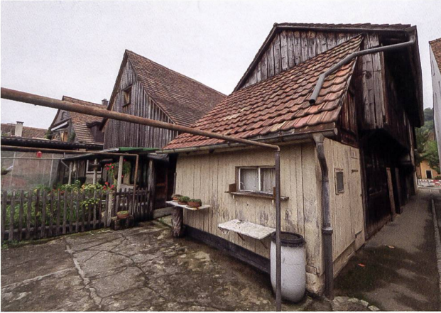
21: Überbaute Hofstätten an der Hauptstrasse. Die Streifenparzellen boten genügend Platz für rückwärtige Gebäudeerweiterungen. Foto 2020.
