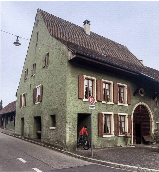
10: Liegenschaft Hauptstrasse 45. Das kantonal geschützte Gebäude musste wegen einer Strassenverbreiterung auf die Stube im Erdgeschoss verzichten. Foto 2022.
