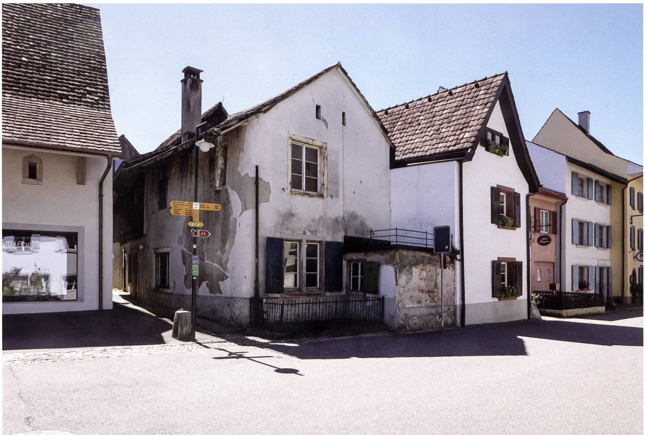
1: Burggasse 8 vor Beginn der Renovierung. Foto 2016.
