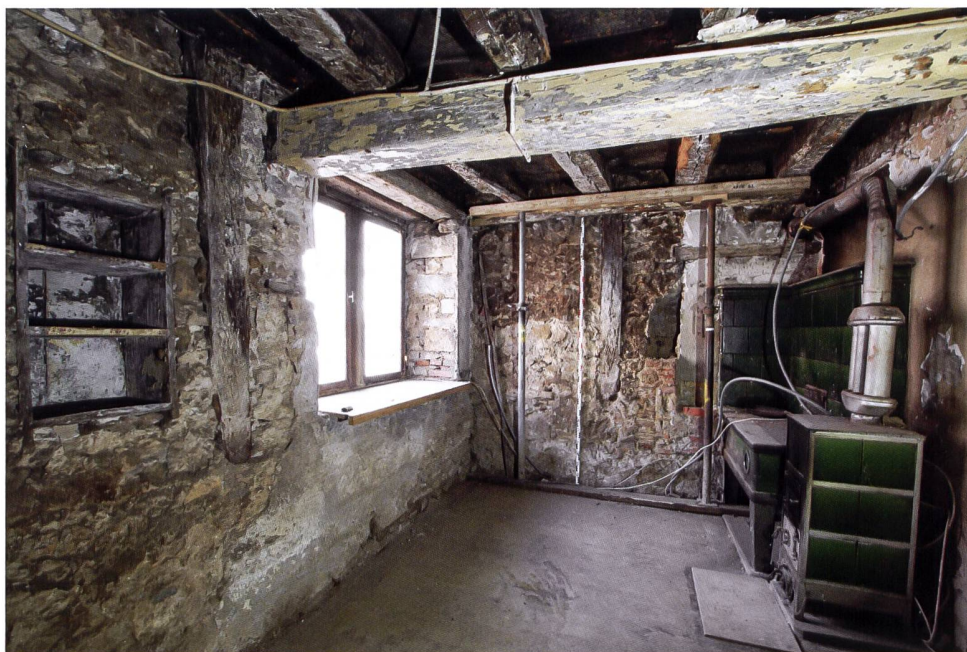
9: Die Stube im Erdgeschoss vor der Renovierung. Foto 2017.
