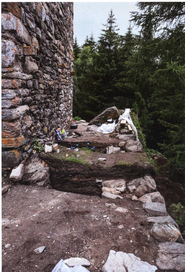
6: Hospental UR, Turm 2021. Das nördliche Burgplateau mit den Sondierflächen F2.3 und F3.1. Es zeigt die engen Verhältnisse zwischen Turmnordseite mit den steinernen Konsolbalken und der Umfassungsmauer. Blickrichtung Südwest.
