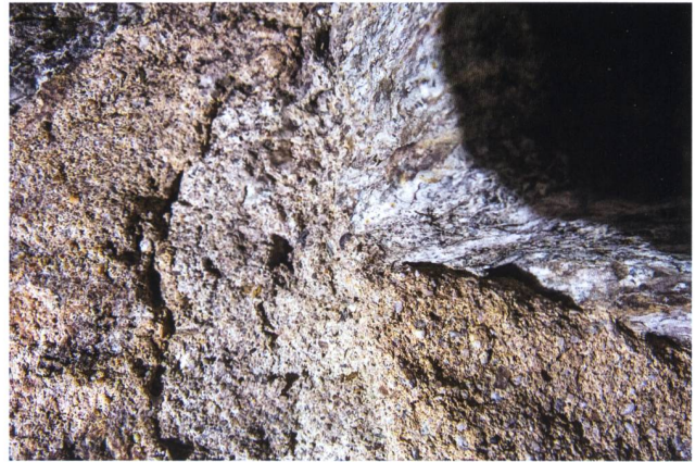
23: Hospental UR, Turm 2021/22. Der bauzeitliche Haufkalkmörtel.
