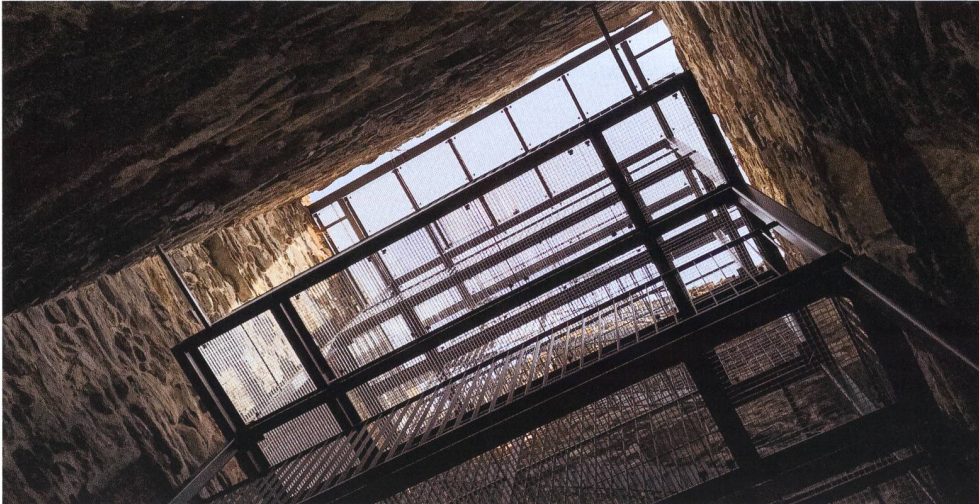
4: Hospental UR, Turm 2021. Einsicht in die bestehende Treppenturm-konstruktion im Turm von Hospental.
