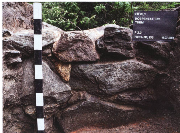
18: Hospental UR, Turm 2021. Ansicht der inneren Mauer- schale von M5 mit sorgfältig gefügten Steinlagen (F2.3). Blickrichtung Nord.
