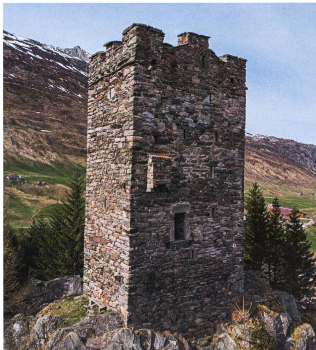
20: Hospental UR, Turm. Die West- (M4) und Süd- (M3) Fassade.
