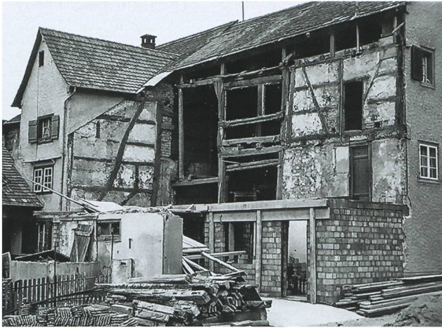
6: Aufnahme während des Umbaus der Steig 5 zu einem Dreifamilienhaus im Jahr 1960. Dabei wurde das hier noch sichtbare Fachwerk aus dem Spätmittelalter (Bildmitte) abgebrochen.
