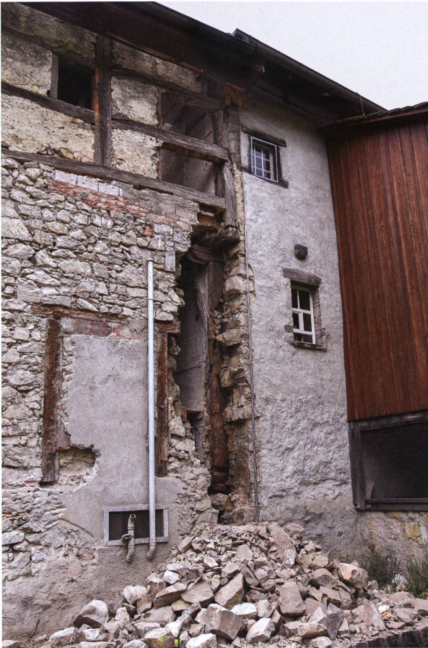
9: Während der Abbrucharbeiten ist an der Schnittstelle beider Hausteile die Versteinerung der Nordfassade gut sichtbar. Die Mauer ist dem Eckständer des Hausteils West (rechts) vorgesetzt und Wartesteine rechnen mit einer baldigen Fortsetzung der Maurerarbeiten im Hausteil Ost (links).
