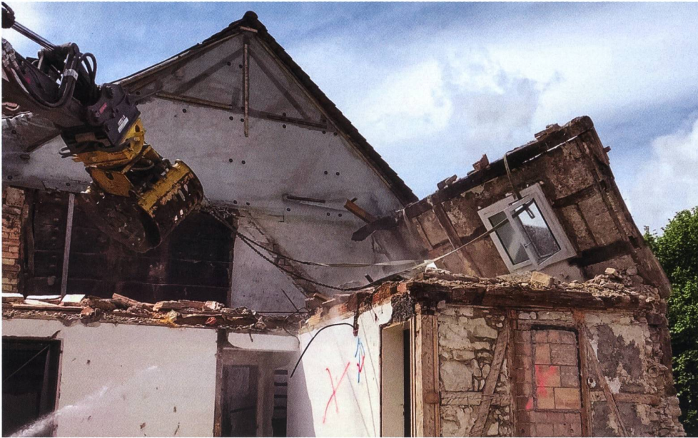
11: Im Mai 2021 wird das Fachwerk von 1472/73 abgebrochen. Hinter der Baggerschaufel ist die Rückseite der Stubenbohlenwand von 1466/67 zu sehen.
