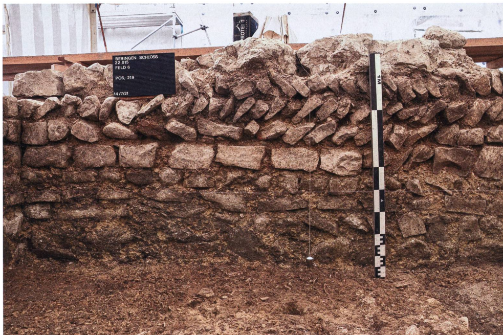
13: Westwand des hochmittelalterlichen Kellers mit dreilagigem Ährenverband ( opus spicatum ).
