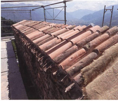
4: Neu-Aspermont, Jenins GR. Die mit neu hergestellten Hohlziegeln ergänzte Kronenabdeckung des Wohnturms. Blick nach Süden, © M. Vasella.
