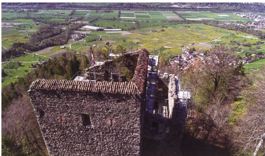
1: Neu-Aspermont, Jenins GR. Blick nach Südwesten auf die Kronenabdeckung von 1466 aus Hohlziegeln, © ADG.
