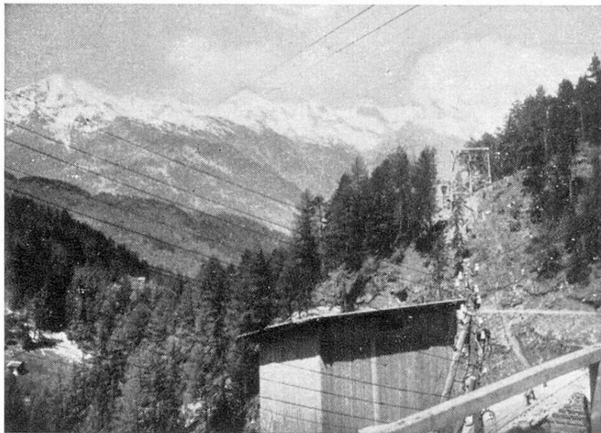
Vue sur les Alpes vaudoises, entrée du chantier
