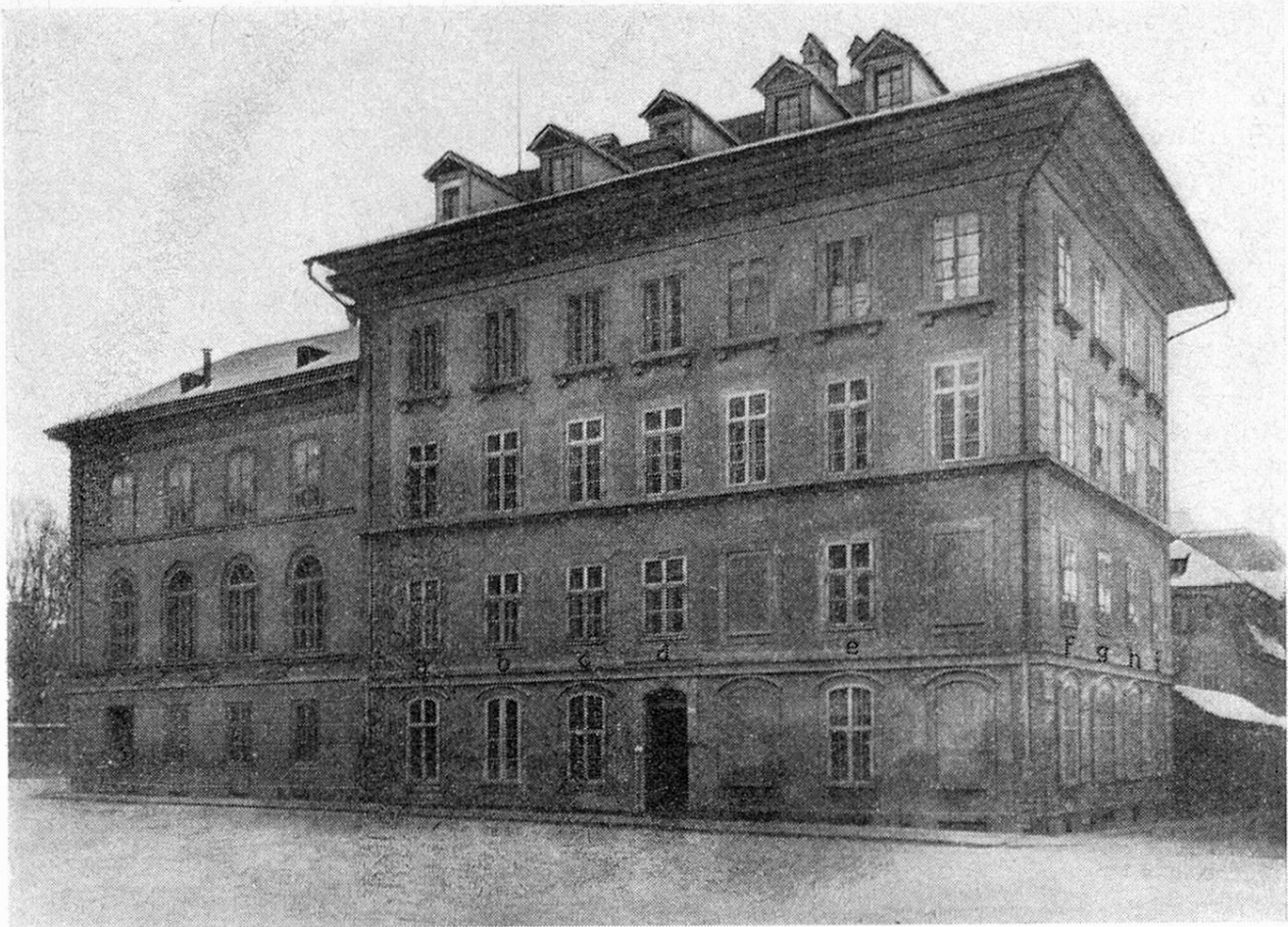
Abb. 7 Staatsapothekengebäude an der Inselgasse in Bern um 1890.
