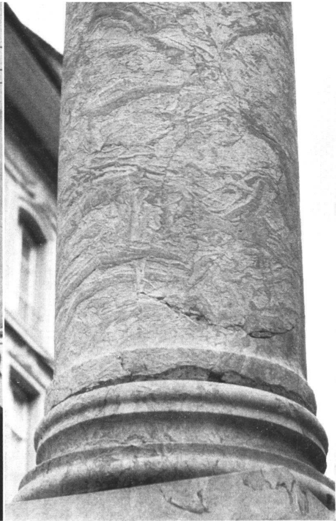
Abb. 11 Nahaufnahme der Säule. Deutlich ist der gegenüber den Korallenbildungen etwas zurückgewitterte Grund erkennbar. Die Basis erscheint jünger.
