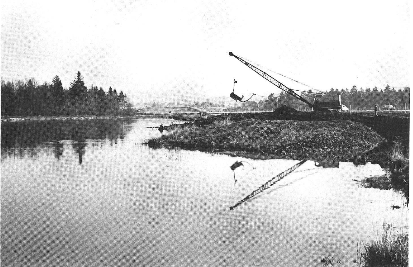
Abbildung 13: Baggersee Hunzigen, Gemeinde Rubigen. Die Insel im Vordergrund ist fertig erstellt, der Bagger arbeitet am Abflachen des Ostufers. Aufnahme R. HAURI, 27. April 1972.
