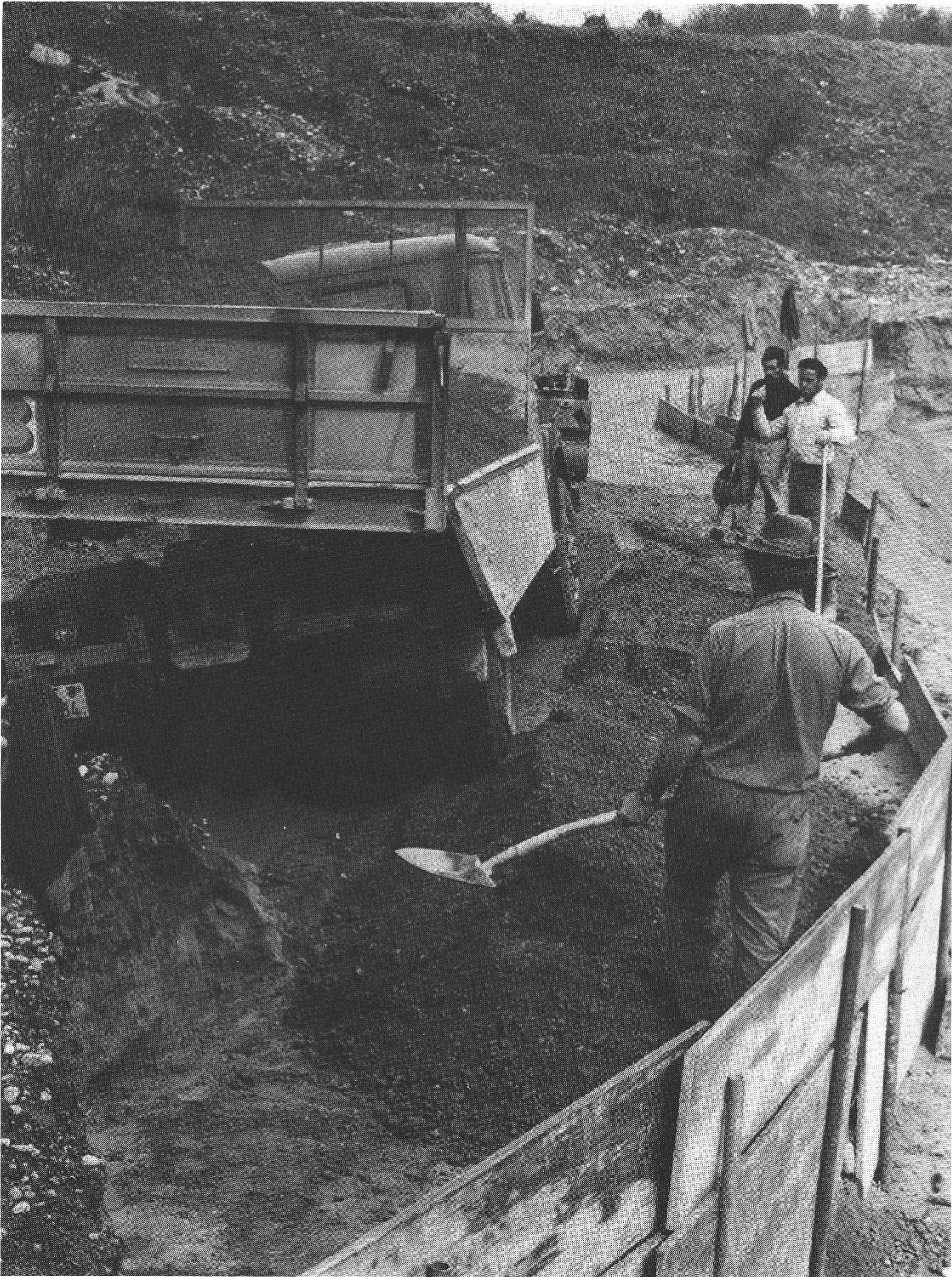
Abb. 9: Einbau der obersten Kiessand/Zementschicht. Foto O. Sieber, 12. April 1979.
