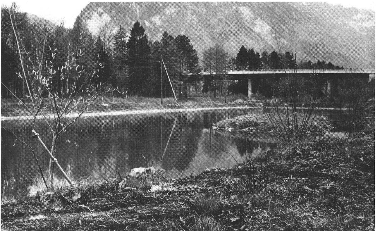
Abbildung 14: Der Lütscherenteich bei Interlaken. Im Vordergrund gepflanzte Sträucher, im rechten Bildteil die Insel. Im Hintergrund der Viadukt der Umfahrungsstrasse Interlaken. (Foto R. Hauri, 20. April 1983)
