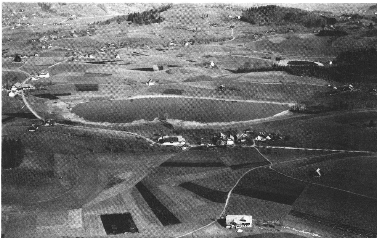
Abbildung 4: Geistsee (im Mittelgrund rechts) und Dittligsee (vorne) von Südosten. Die Ufer des Geistsees sind noch nahezu baum- und strauchfrei. (Luftaufnahme Alpar vom 5. April 1937, Foto freundlicherweise von der Alpar zur Verfügung gestellt.)
