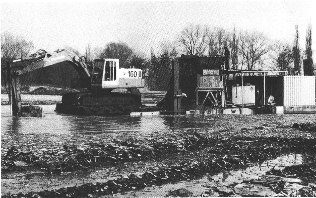
Abbildung 3: Bau des Kanal-Teichsystems. Mit dem auf ein flexibles Floss befestigten Hydraulikbagger können die flachufrigen Kanäle und Teiche erstellt werden. Das Material wird in den Trichter (Bildmitte) geleert, zerkleinert und mit den ebenfalls auf dem Floss installierten Pumpen durch die schwimmende Transportleitung in die Auflandebecken befördert. (Aufnahme C. Marti, 11. März 1987)
