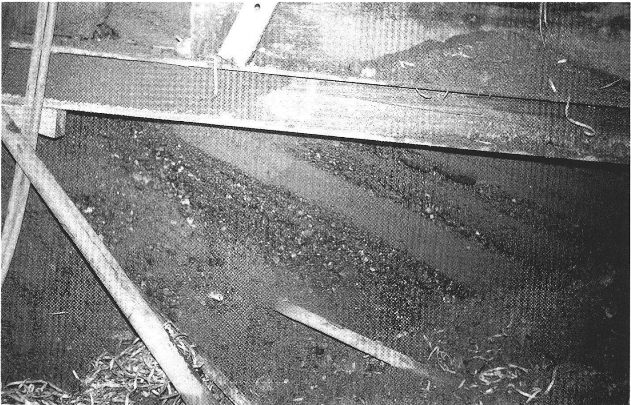
Textfigur 10: Wysslochrinne (Schosshalde) 60 m unter OK Terrain
