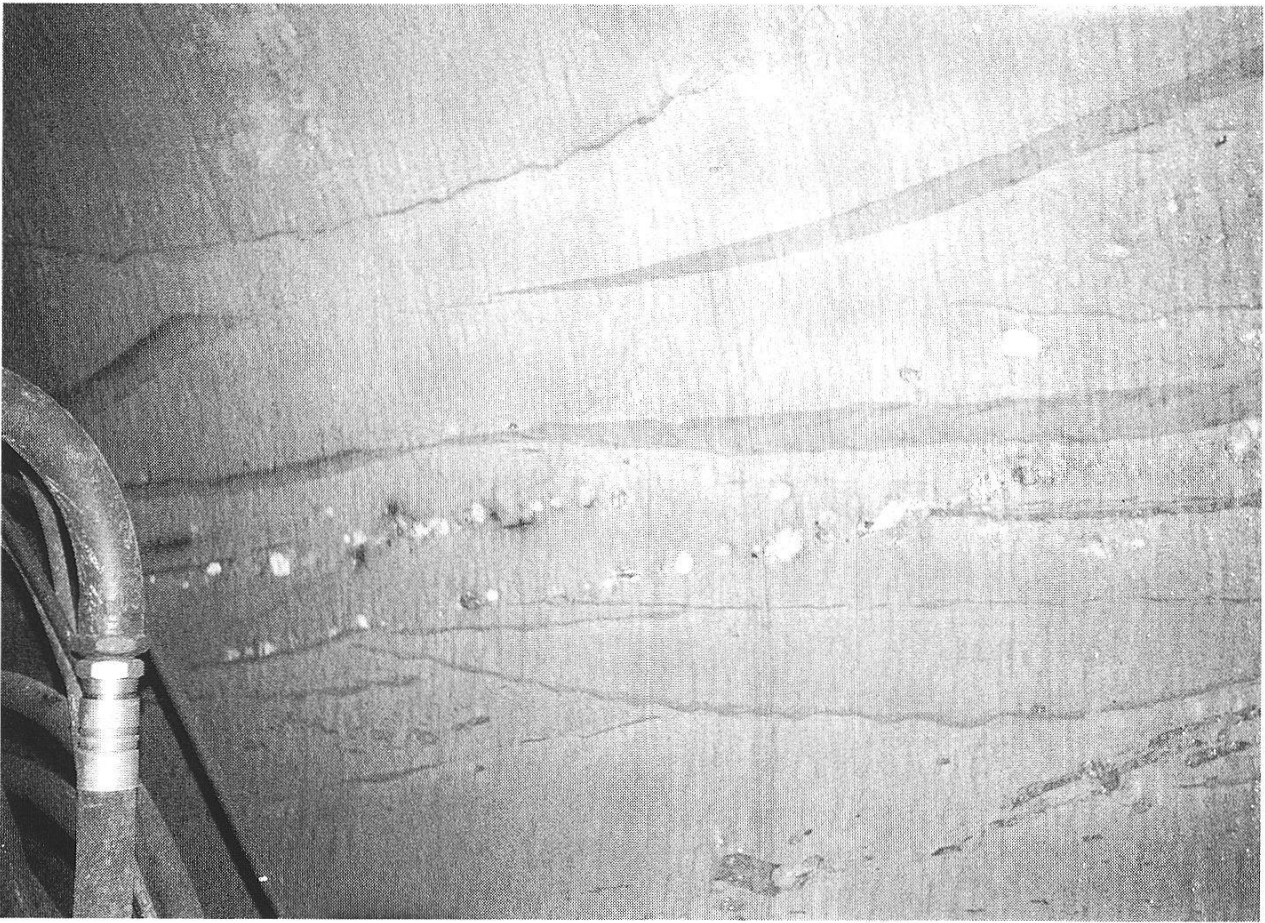
Textfigur 5: Der Berner Sandstein (Burdigalien) in einem 1987 gefrästen Stollen, nur etwa 150 m vom aufgelassenen Steinbruch Klösterli entfernt und stratigraphisch dem mittleren Niveau des Steinbruchs entsprechend. Hell: Geröllschnüre / Dunkel: Mergellagen.
