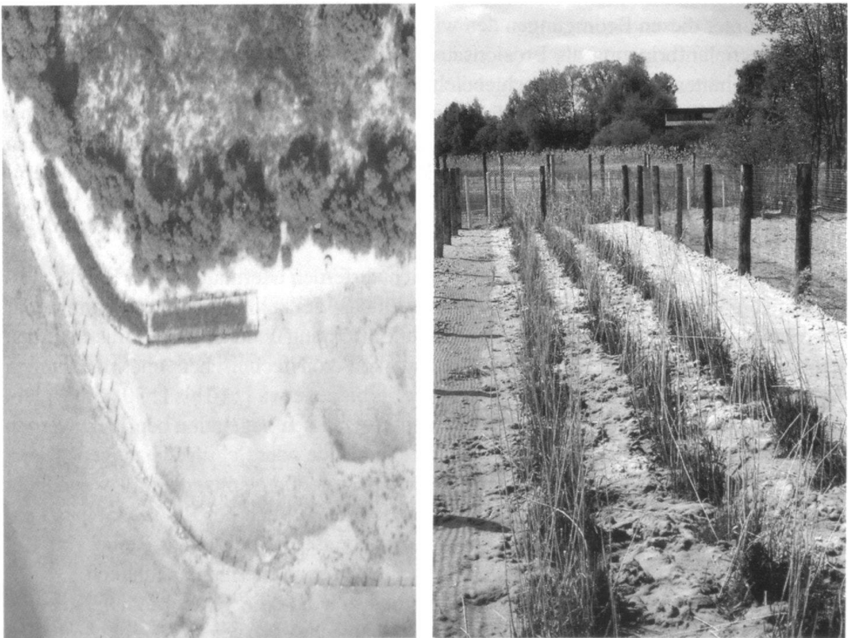
Abbildung 4: Sandaufspülungen an der Lipbach-Mündung bei Friedrichshafen (Landkreis Bodenseekreis) (links: Luftbildübersicht, gepflanzte Schilfbestände, rechts: Schilfpflanzung).*
