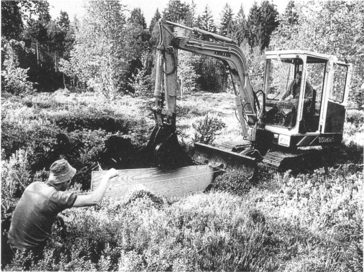
Image 5: Mise en place d'un panneau de bois marin pour fermer un canal de drainage. (Photo Ph. Grosvernier)
