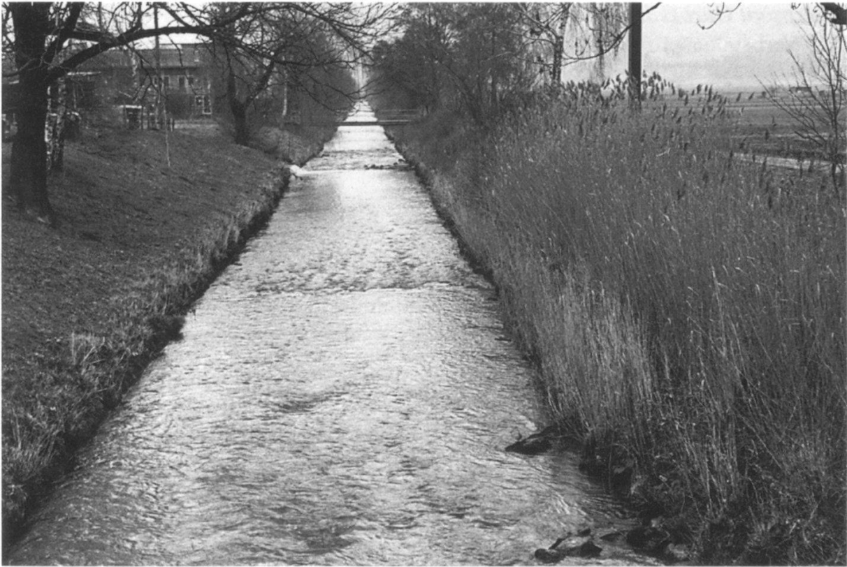
Für den Talboden repräsentativer Gürbeabschnitt bei Mühlethurnen (Probestelle II) mit gleichförmigem Trapezprofil; Sicht abwärts.
