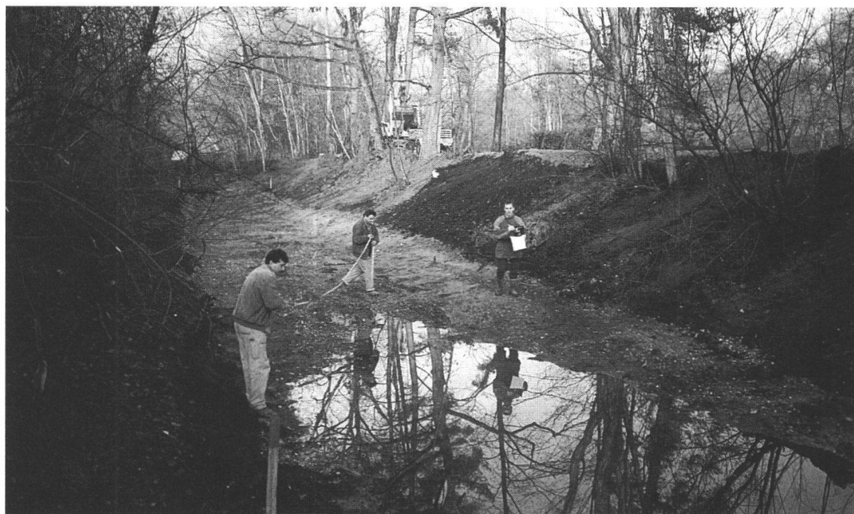
Abbildung 11: Ausbaggerung von verschlammten Tümpelbereichen. Die variierenden Tiefen des Aushubes gewährleisten verschiedene Lebensräume für wasserbezogene Lebewesen. (Foto: P. Weber, Dezember 1994)
