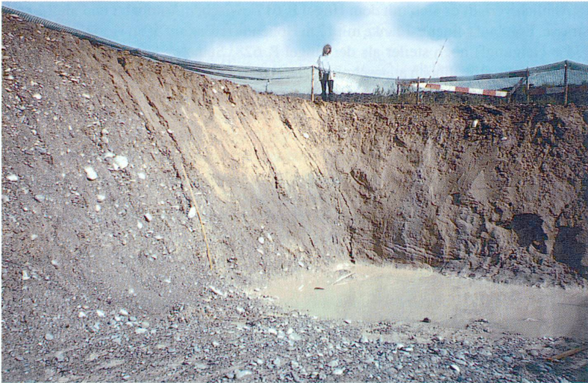
Abbildung 8: Die Baugrube in dem Hügel P. 584 (vgl. Abb. 6 und 7) zeigte 1994 ungeschichtetes Moränenmaterial, das nach NE (in der Fliessrichtung des Gletschers) längs einer steilen Grenzfläche in homogenen Feinsand überging. Blickrichtung N.
