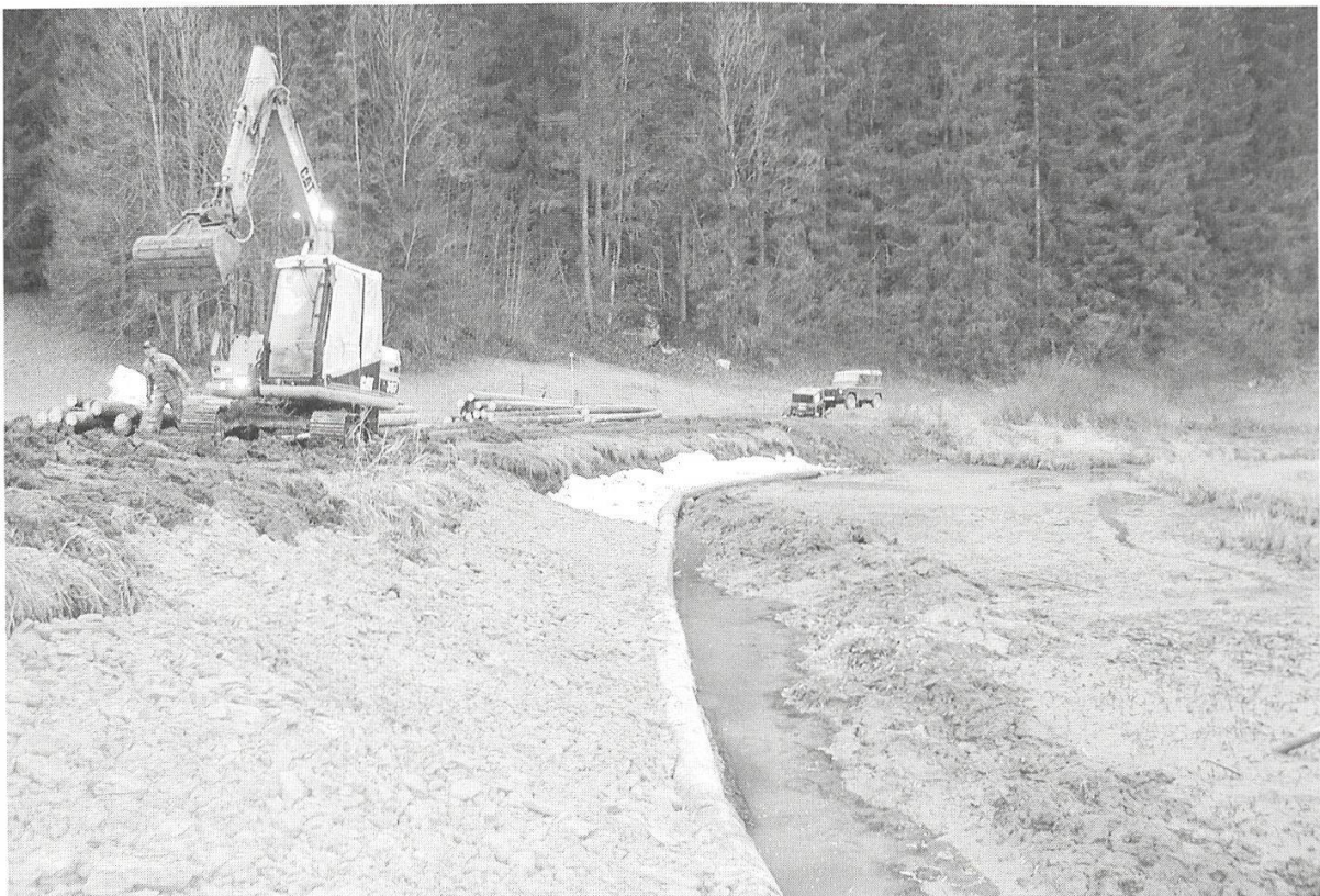
Abbildung 6: Renaturierungsarbeiten am Südufer des Lenkersees. (Foto: W. Frey, April 2004)
