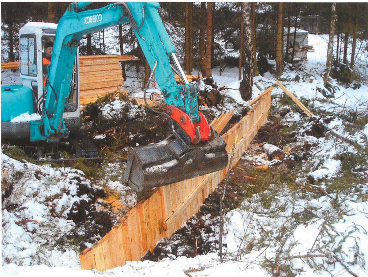
Abbildung 5: Doppelwandiger Sperrenbau Siehenmoos. (Foto: Naturschutzinspektorat, Dezember 2005)
