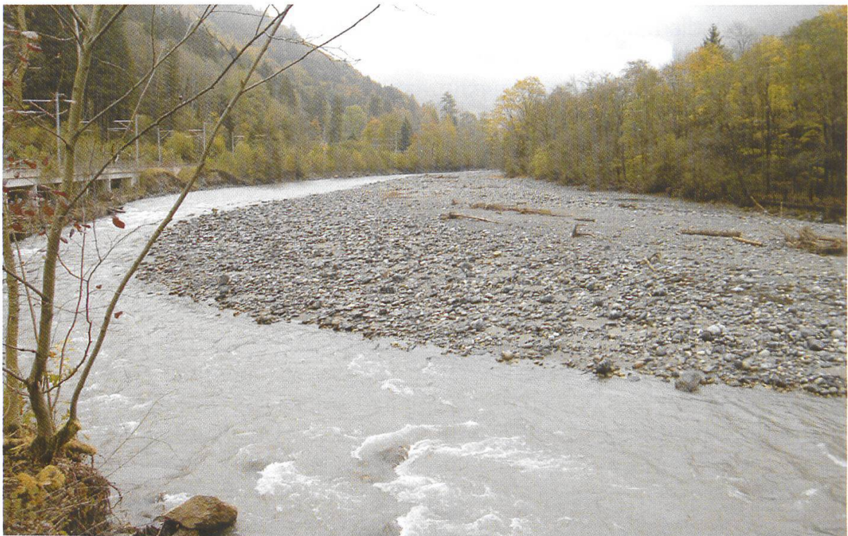
Abbildung 19: Situation nach dem Hochwasser vom August 2005. Das Unwetter hat die Auenlandschaft neu gestaltet. Vorher war das Bahntrasse der BOB (links im Bild) ca. 40 m von der Lüttschine entfernt. (Foto: IMPULS, Oktober 2005)
