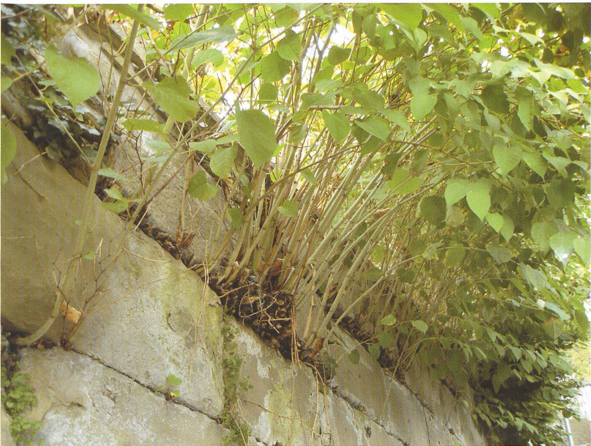
Abbildungen 27 und 28: Durch den Japanischen Staudenknöterich werden Bachufer destabilisiert und Bauten geschädigt. (Foto: E. Jörg, 2005)
