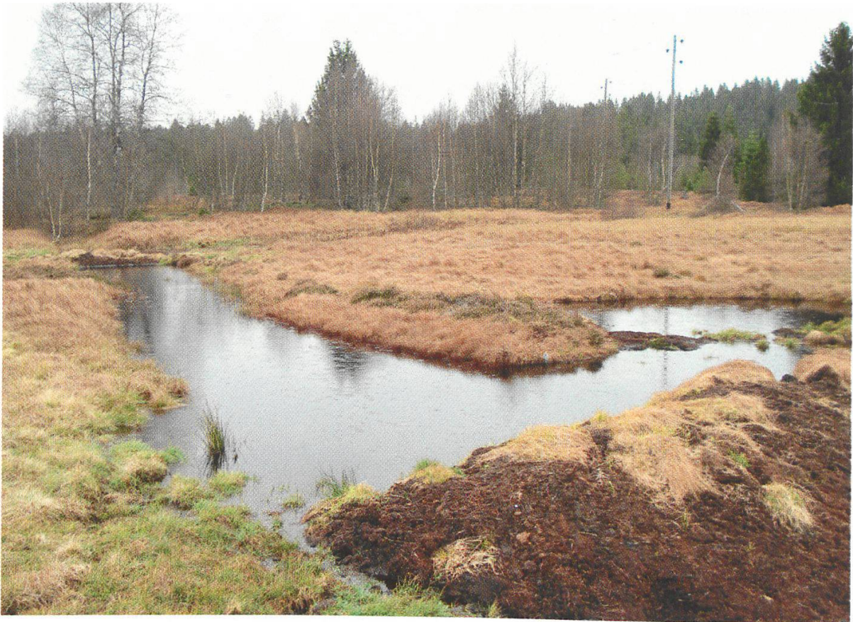
Abbildung 4: Bau eines Staudammes zwecks Rückhaltung des Wassers im Hochmoor von La Chaux (Gemeinde Tramelan). (Foto: S. Guerne, Oktober 2006)
