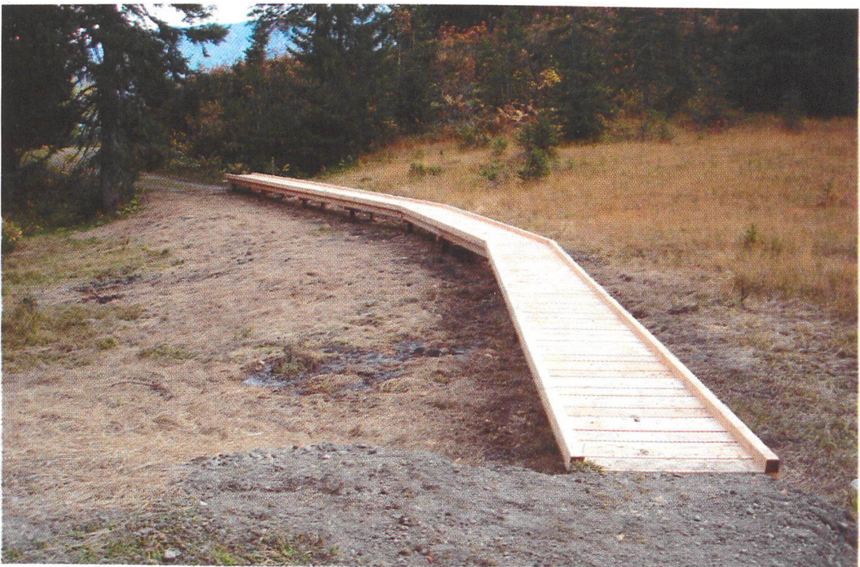
Abbildung 13: Die Querung der trittempfindlichen Flächen erfolgt über den neuen Moorsteg. (Foto: R. Wyss, Oktober 2006)
