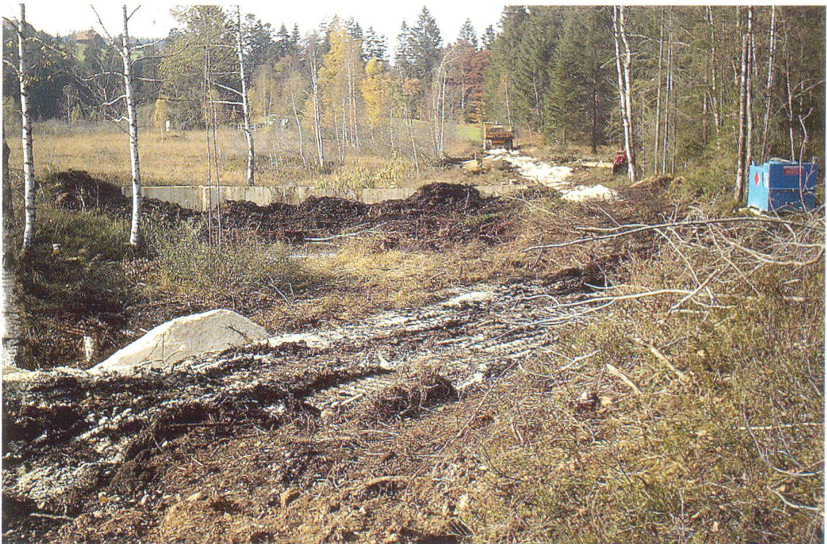
Abbildung 9: Die Moorregenerierung bedingt eine «Grossbaustelle», damit der Hauptgraben auf einer Gesamtlänge von 211 m fachtechnisch aufgefüllt werden kann! (Foto: Naturschutzinspektorat, November 2007)
