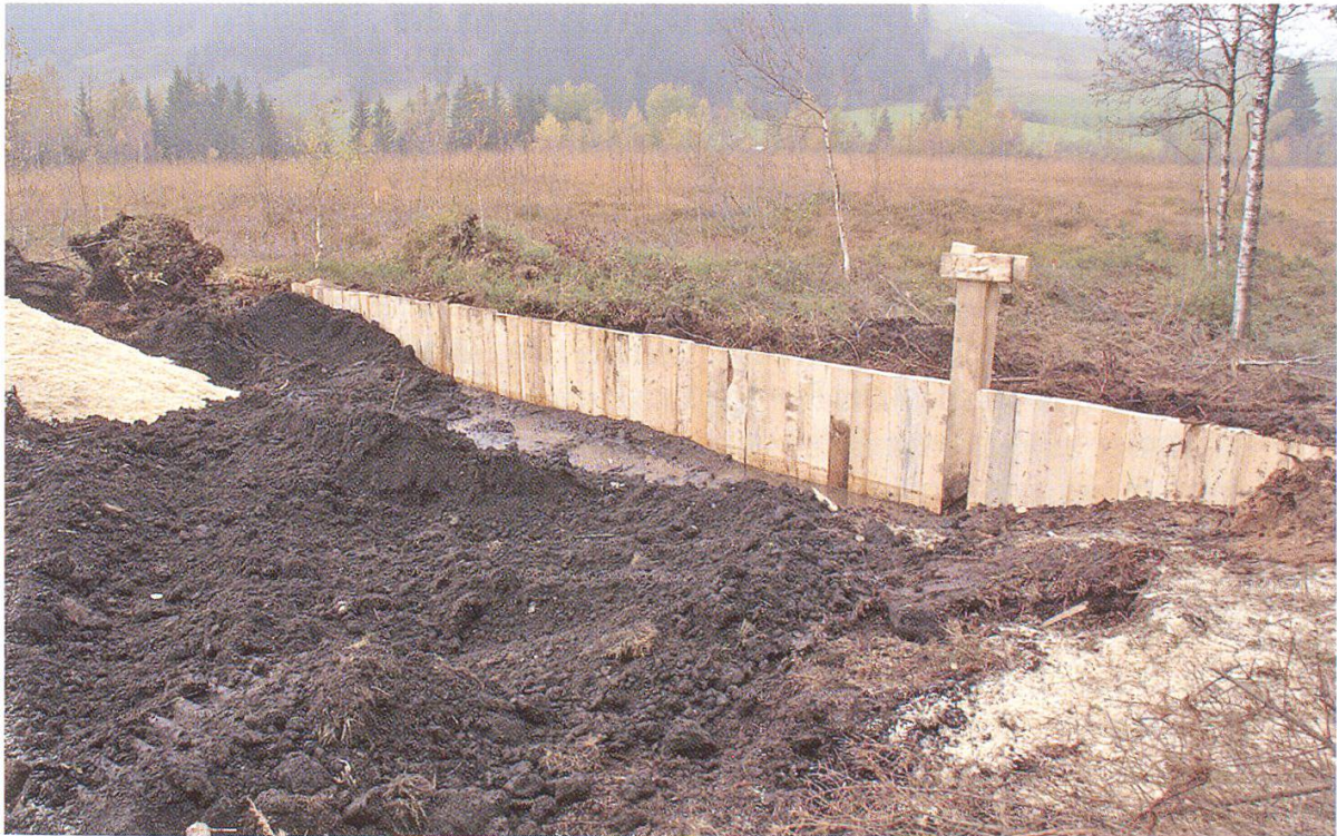
Abbildung 8: Einbau von grossen Holzsperrren, damit das Einfüllmaterial nicht weggeschwemmt wird. (Foto: Naturschutzinspektorat, November 2007)
