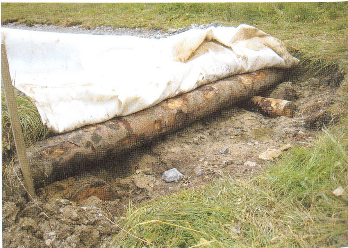
Abbildung 7: Unterbau mit Holzprügellage und Vlies für den Bewirtschaftungsweg im Naturschutzgebiet Unterer Stauffen, Habkern. (Foto: NSI, Aug. 2008)
