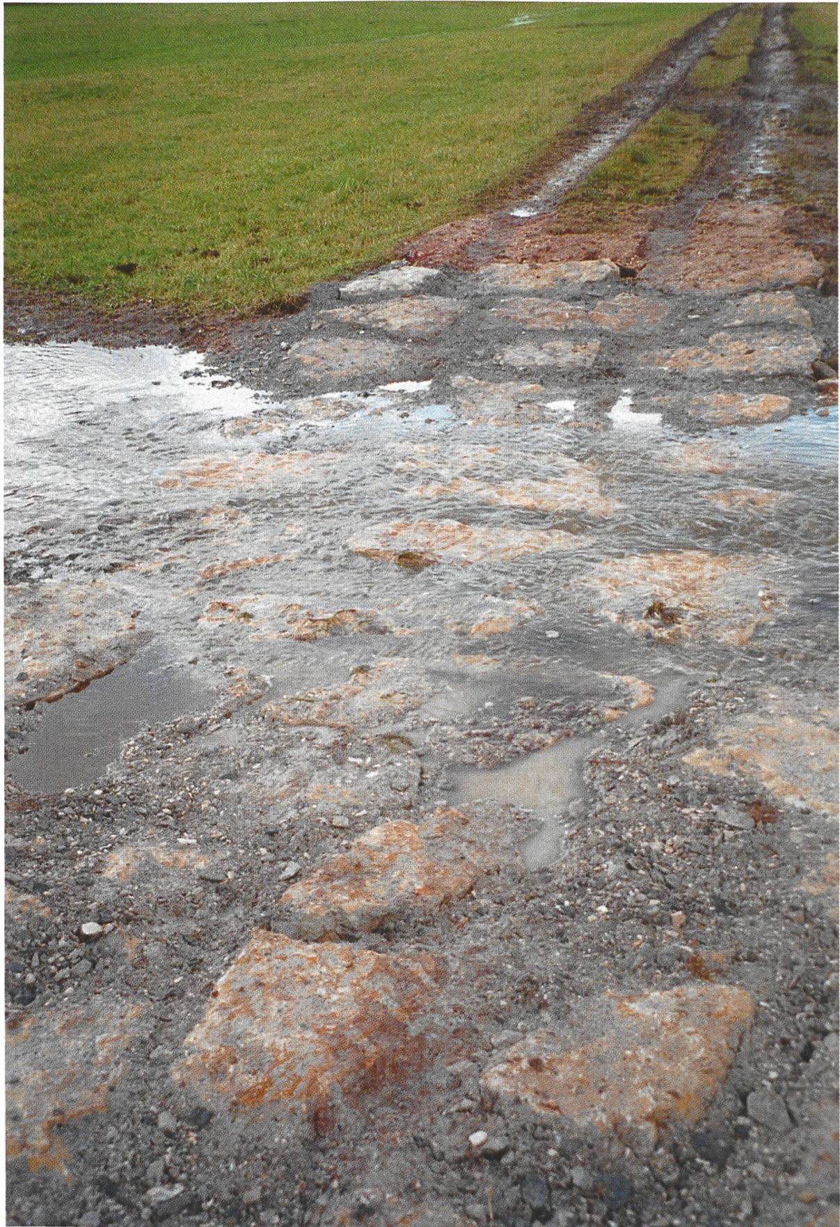
Figure 9: Détail sur un passage à gué (photo: S. Guerne, 2009)
