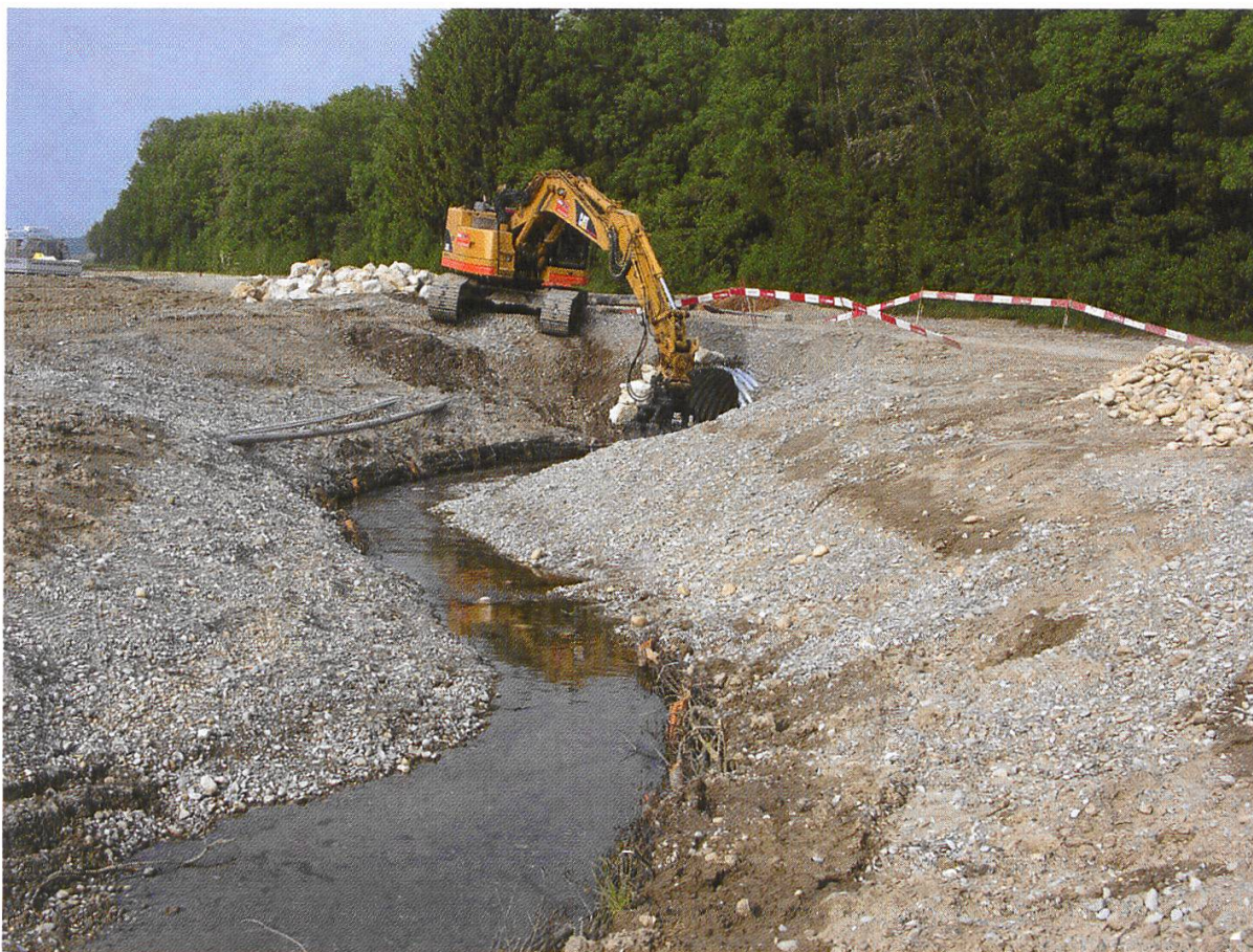
Abbildung 12: Während der Bauphase wirken die Eingriffe häufig massiv.
