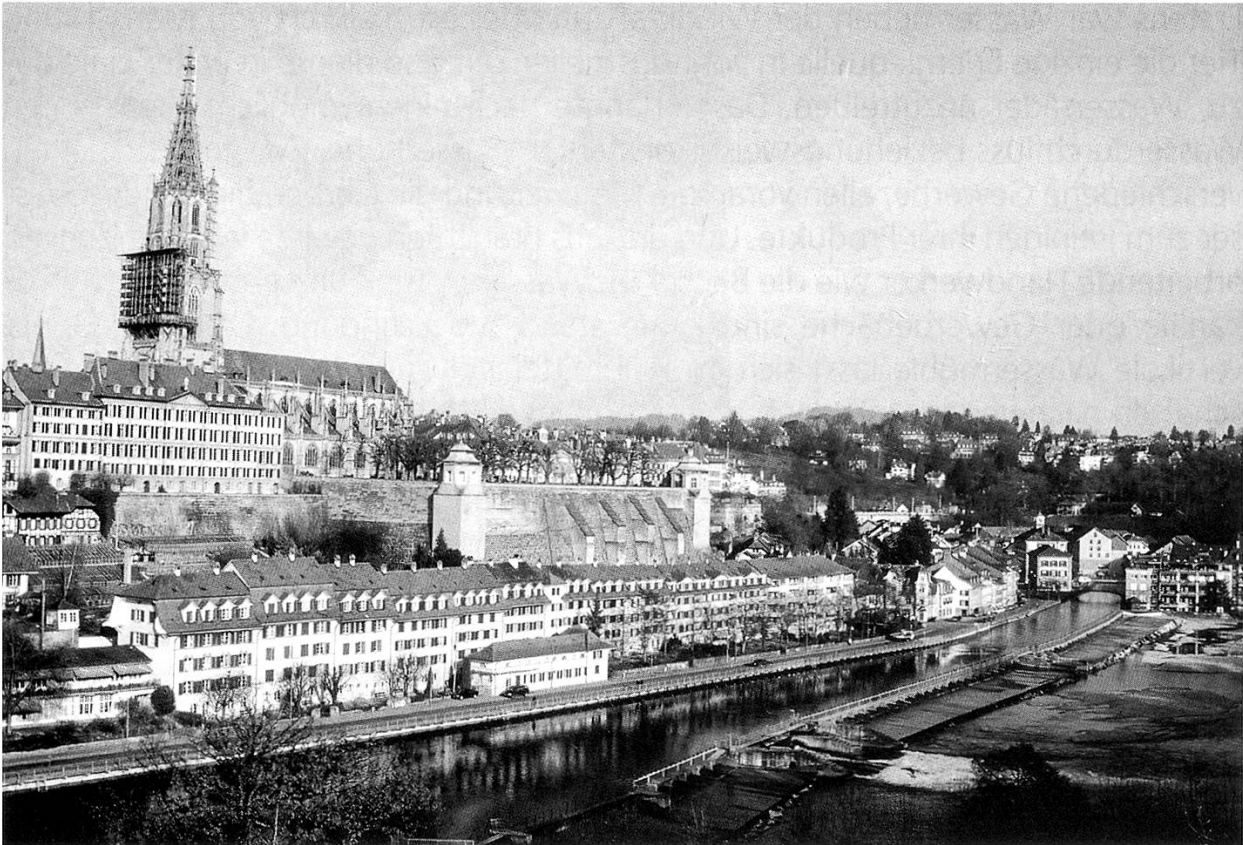
Abbildung 12: Die Mattenschwelle und das Gewerbequartier Matte. Fotografie von 2004 (Foto: Armand Baeriswyl).
