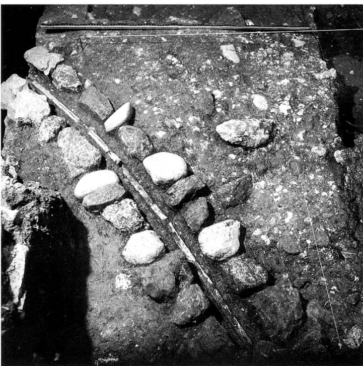
Abbildung 1: Die ergrabene Wasserleitung des ehemaligen Cluniazenser-Priorats auf der St. Petersinsel (Bielersee). Sie bestand aus Bleirohren, die von seitlich gestellten Steinplatten und Deckplatten geschützt waren. Frühes 12. Jahrhundert (GUTSCHER/UELTSCHI/ULRICH-BOCHSLER, St. Petersinsel, Abbildung 282) 4 .
