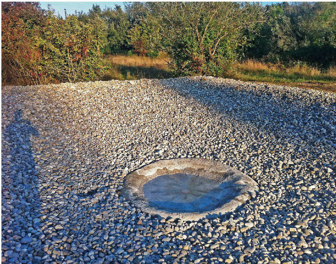
Figure 14: L'étang en gravier possède en son centre un système de vidange protégé par une collerette en béton maigre afin d'éviter l'obstruction de la conduite par le gravier. (Photo: Olivier Bessire)
