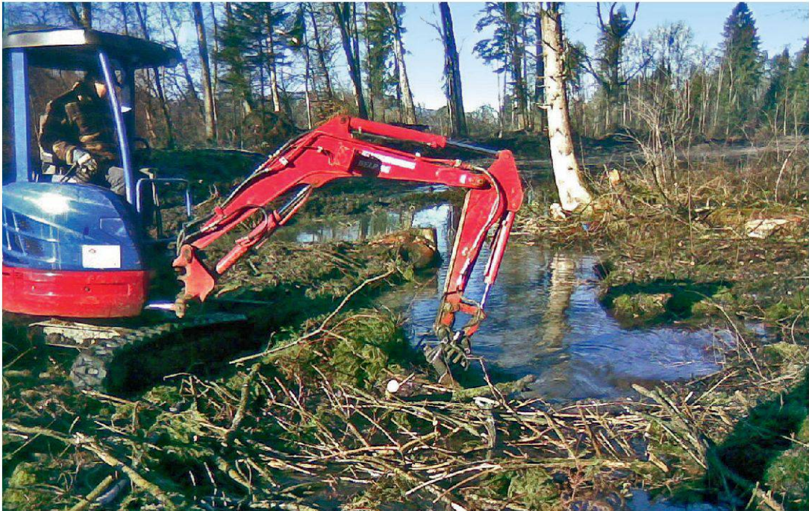
Abbildung 17: Bei kleineren Giessen wird das Holz geräumt und der Schlick entfernt. Einzelne Bereiche werden dabei unbearbeitet belassen. Angestrebt wird eine durchschnittliche Wassertiefe von 20–30 cm. «Hinderi Au», Winter 2008. (Foto: Christoph Forrer)
