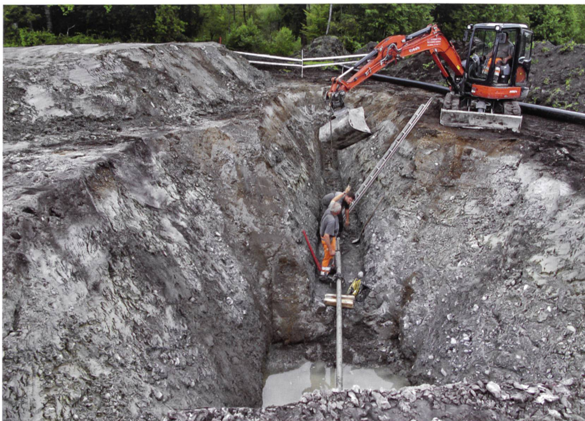
Abbildung 14: Zielgrube der Ersatzleitung nach Abschluss der Pilotbohrung. Im Hintergrund befindet sich das «Lörmoo». (Foto: Thomas Leu)
