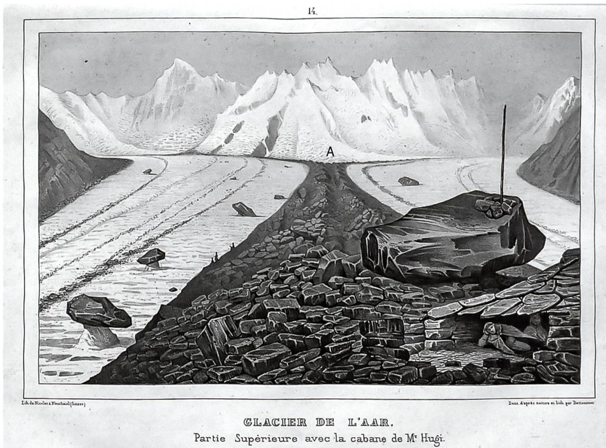
Abbildung 6: Die Steinhütte auf der Mittelmoräne, die Hugi 1829 beim Abschwang (A) auf der dort entstehenden Mittelmoräne gebaut hatte, wie sie Agassiz bei seiner ersten Begehung im Sommer 1839 antraf. (J. Bettannier, «Glacier inférieur de l'Aar», in Louis Agassiz, «Études sur les glaciers», 1840)
