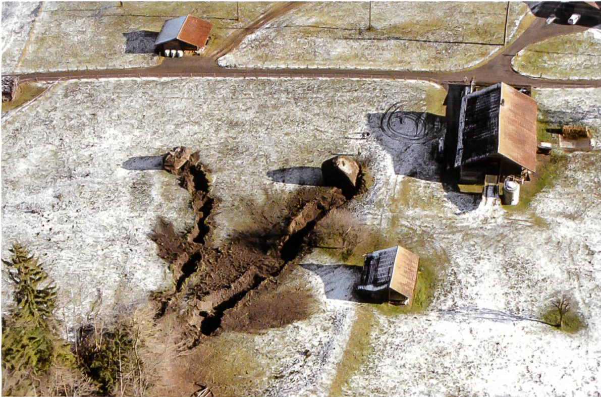
Abbildung 9: Im Dezember 2007 stürzten nach Schneeschmelze und anschliessender Kälte zwei Grossblöcke von rund 150m 3 und 100m 3 in den Talboden von Kandergrund.
