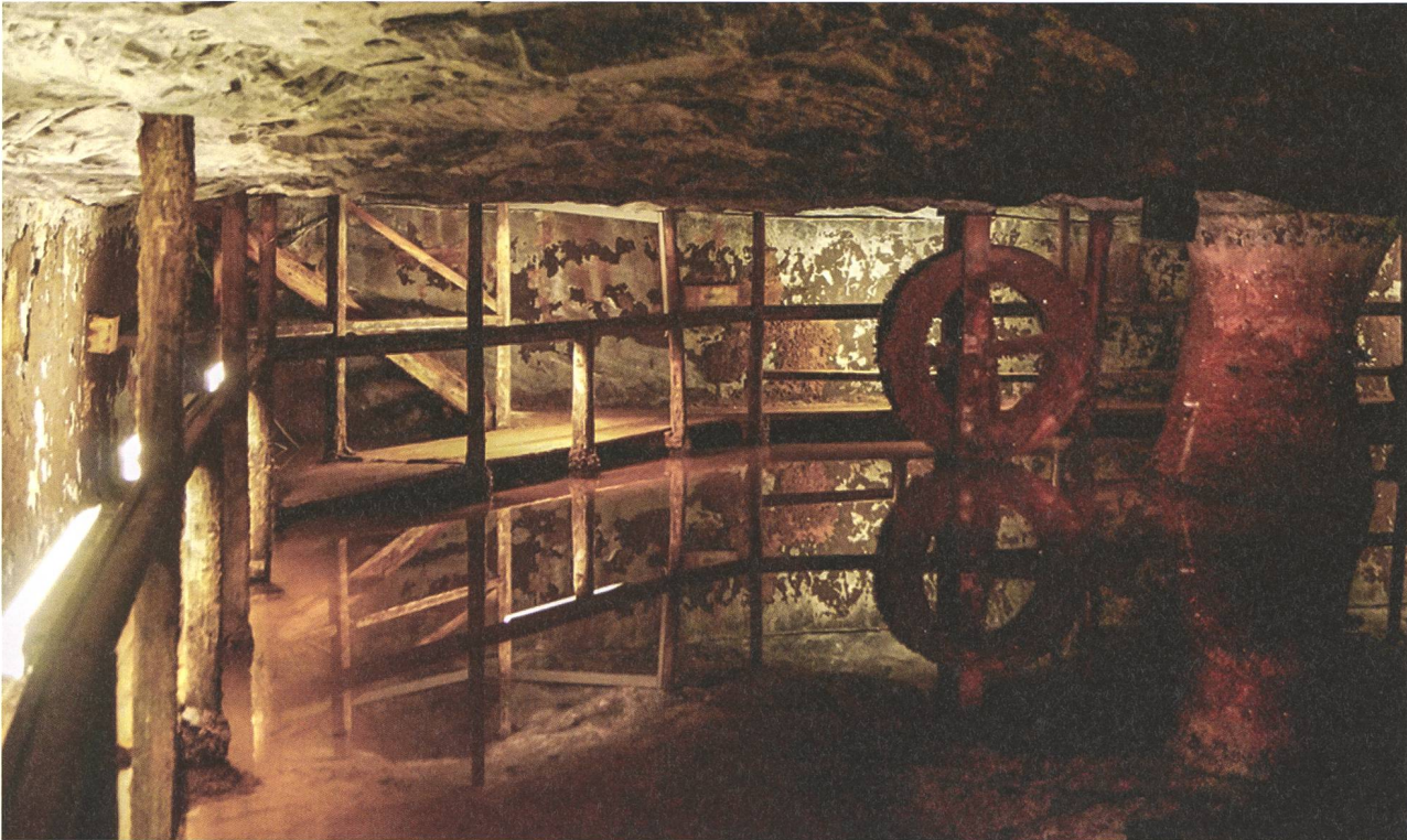
Blick in das «Réservoir Marie-Louise», welches als Ausgleichbecken für die Sole diente.
