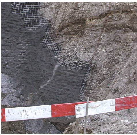
Tafel 1, Foto 1: Baugrubenabschluss Süd. Glaziale Schotter im Hangenden der Seesedimente mit diskordanten Mergellagen und Verwitterungshorizonten, vermutlich Münsingen-Schotter bzw. sog. Spiezer Schwankung.
