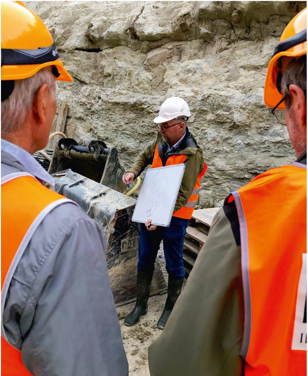
Abb. 4 und 5: Blick auf die alte, noch befahrene RBS-Tunnelröhre. Fritz Schlunegger erklärt die Sedimentationsgeschichte der Fluss-Rinnenstruktur.
