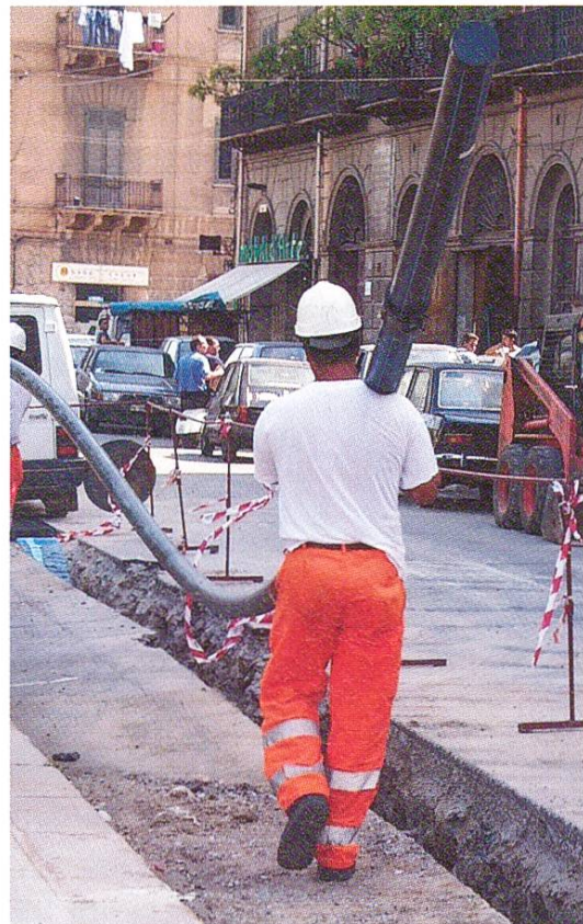
Abb. 2: Grabenverlegung einer Polyethylen-Wasserleitung in Palermo
