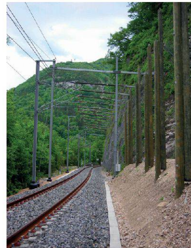
Figure 13. –Filets de détection verticaux et horizontaux (La Crotte); photo BG / Hugues Foltzer.
