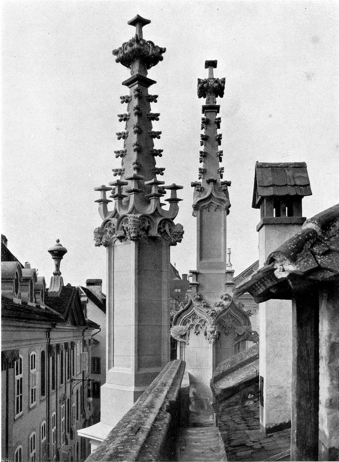
Fiale an der Südwestecke
