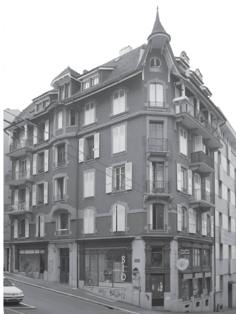
2 Cet immeuble à la rue du Valentin, construit en 1911 par les architectes Baud & Hoguer, est caractéristique du « paysage urbain » lausannois, avec la silhouette découpée de sa toiture d'inspiration Heimatstil et ses devantures en bois qui ont subsisté (Photo M. Jaquet).
