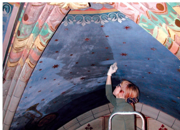
10 Voultain du chœur, en cours de nettoyage (élimination d'une épaisse couche de saleté) (Photo J. James, 2010).
